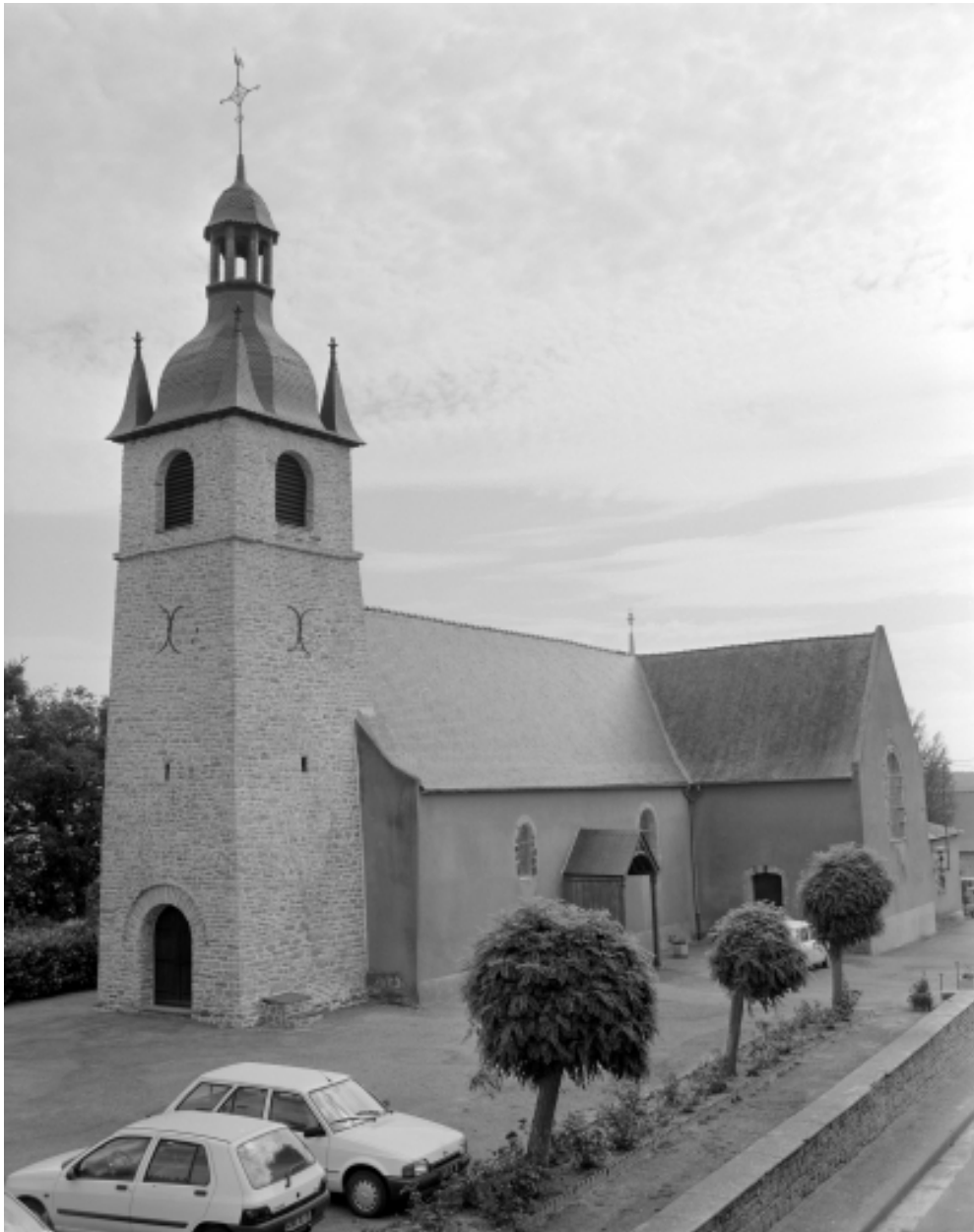
Elévation sud-ouest : vue générale
