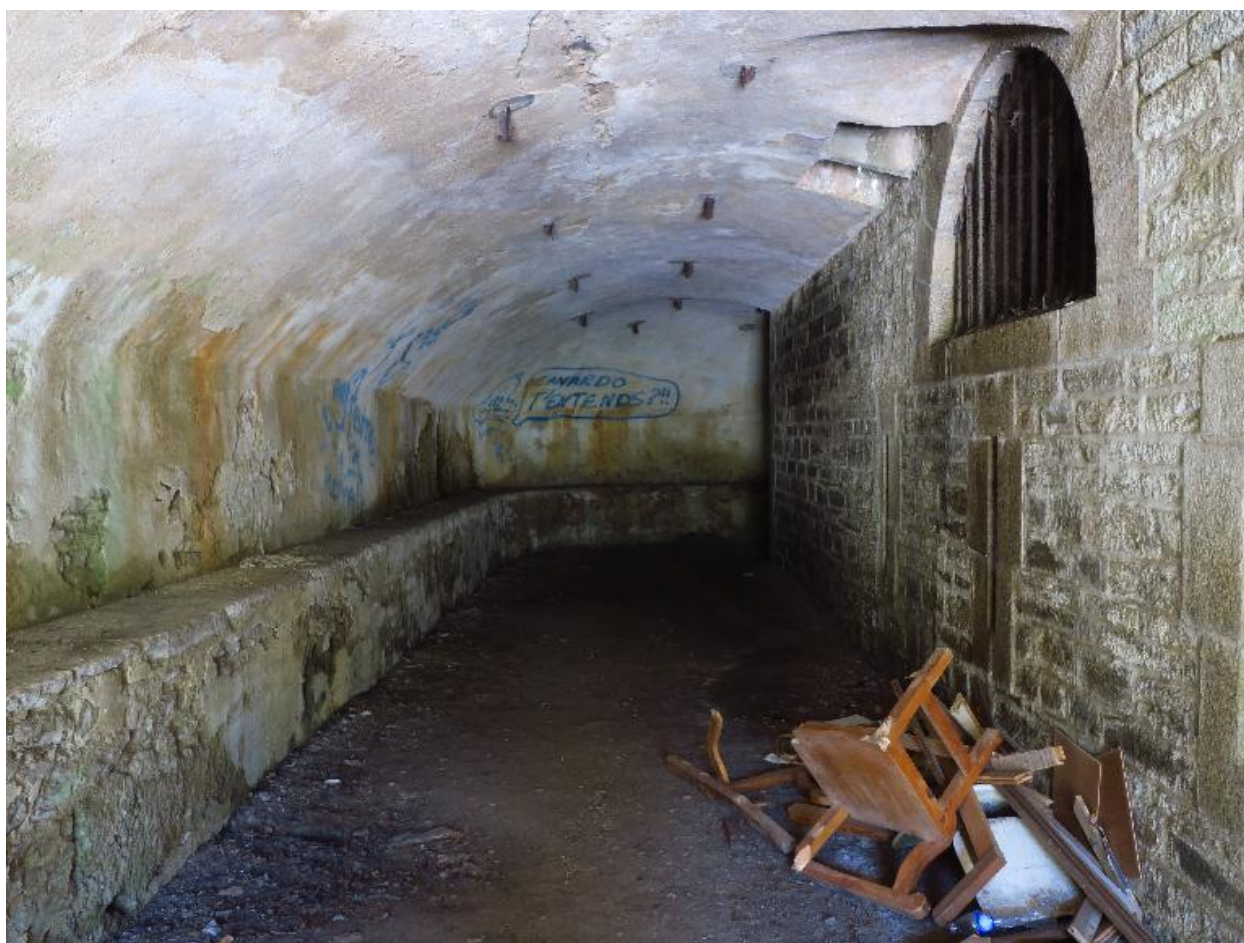
Groix, batterie du Bas-Grognon, corps de garde crénelé, couloir voûté latéral.
