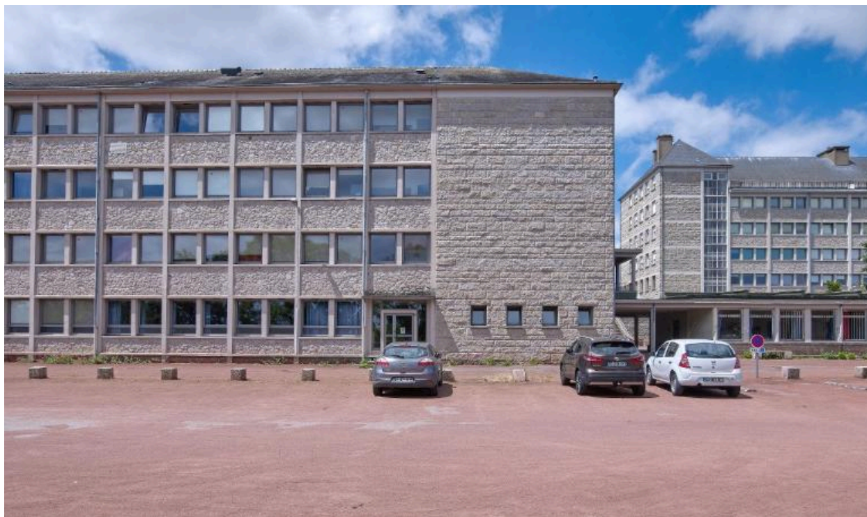
Vue partielle des façades ouest de l'externat et de l'internat de garçons - externat.
