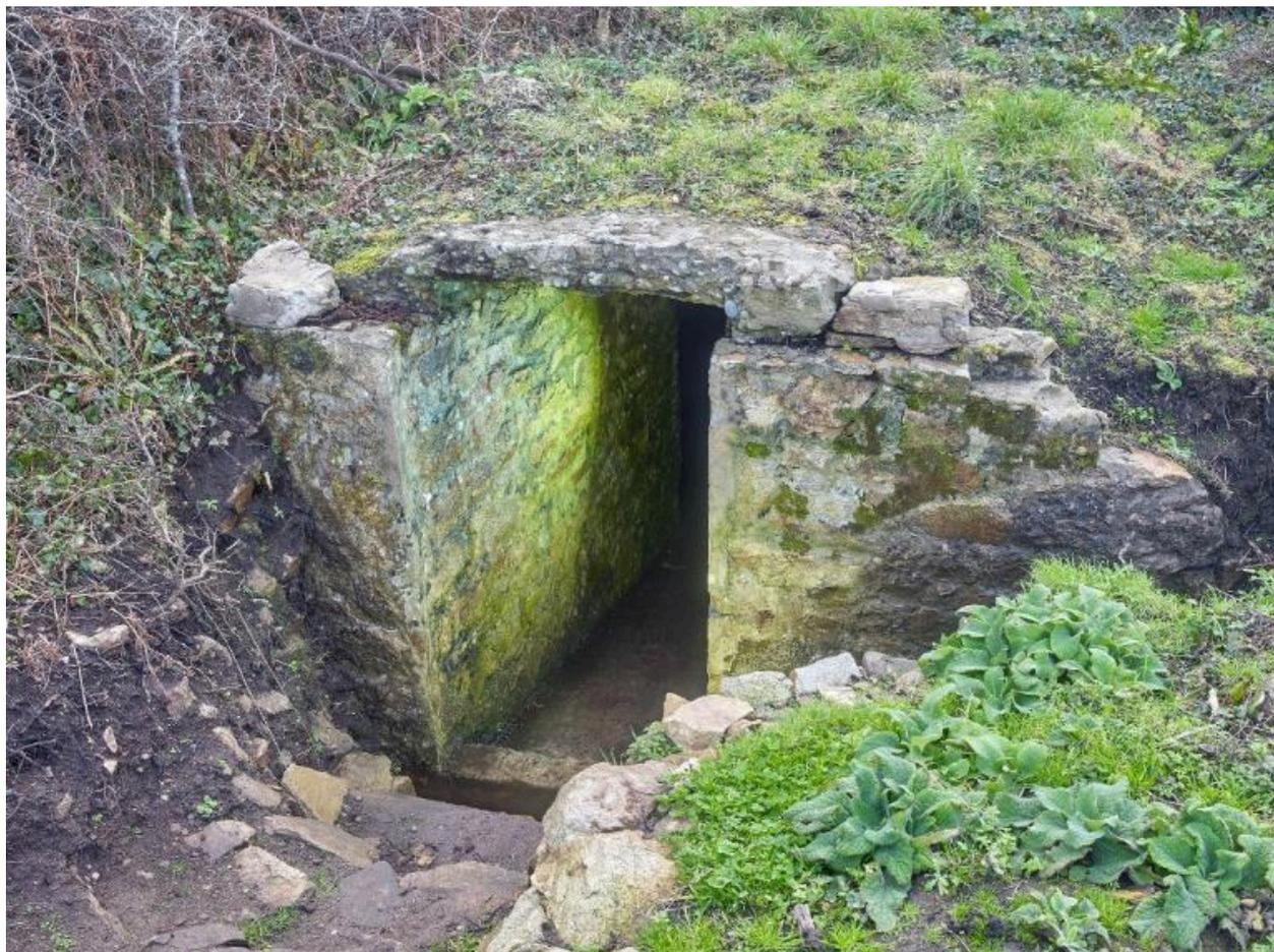
Vue d'une construction de campagne : entrée orientée vers le nord. Enterrée dans le sol, cette construction dispose de murs et de deux piliers en maçonnerie couverts d'une dalle en béton d'environ 30 cm d'épaisseur
