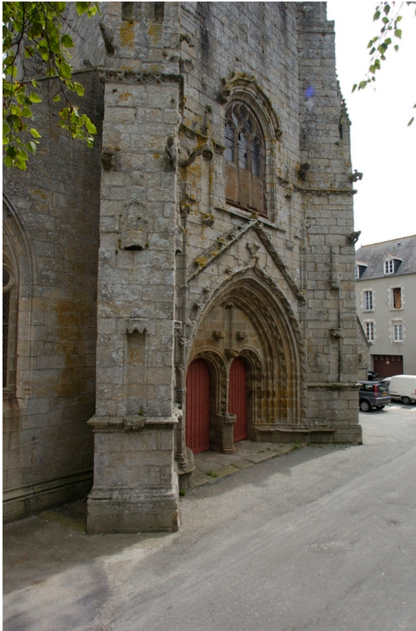
Vue du porche au pied de la tour occidentale
