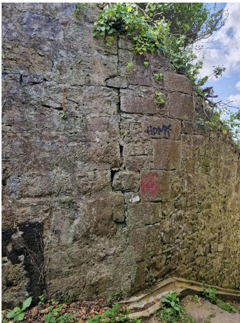
Vue de la jonction entre le fossé sec de la redoute et l'escalier menant à la batterie basse (état en 2024)
