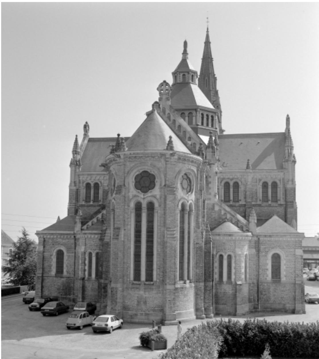
Elévation Nord-Ouest : vue générale
