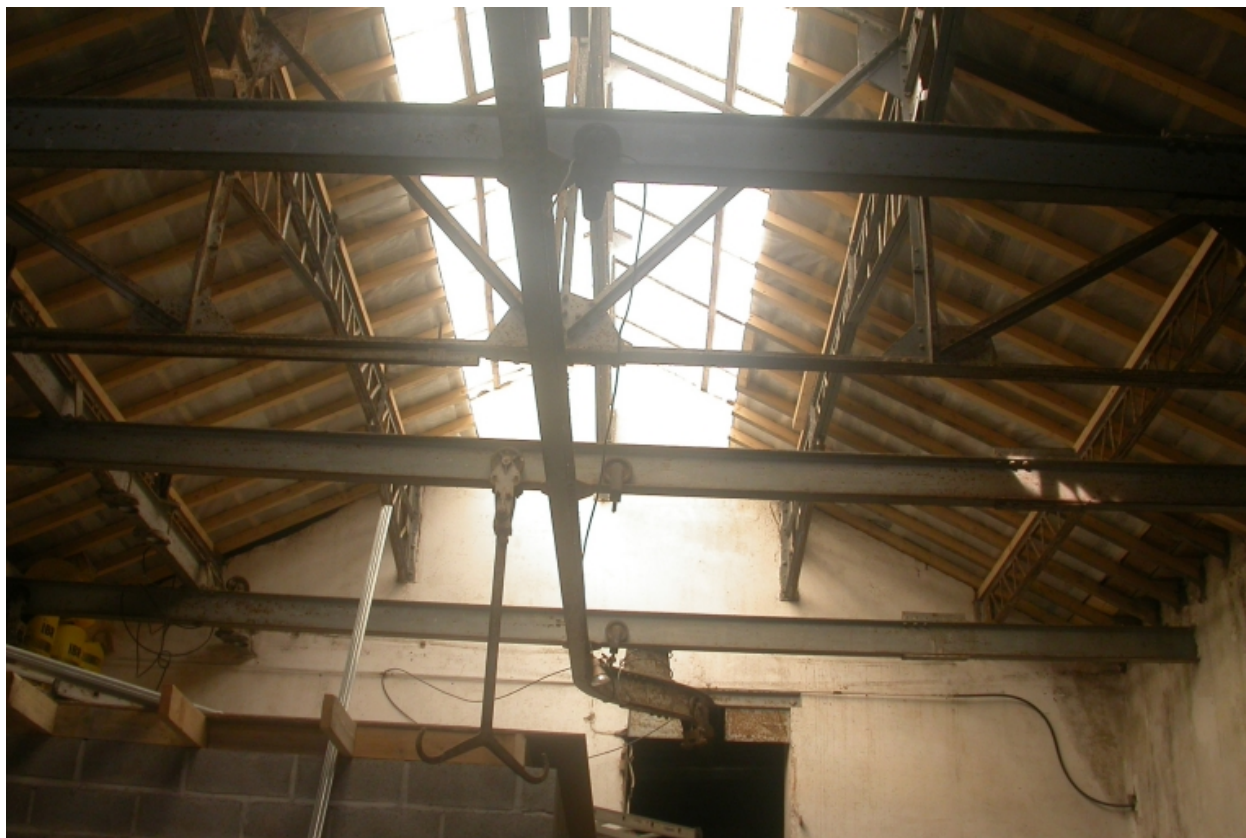
Vue générale de la charpente
