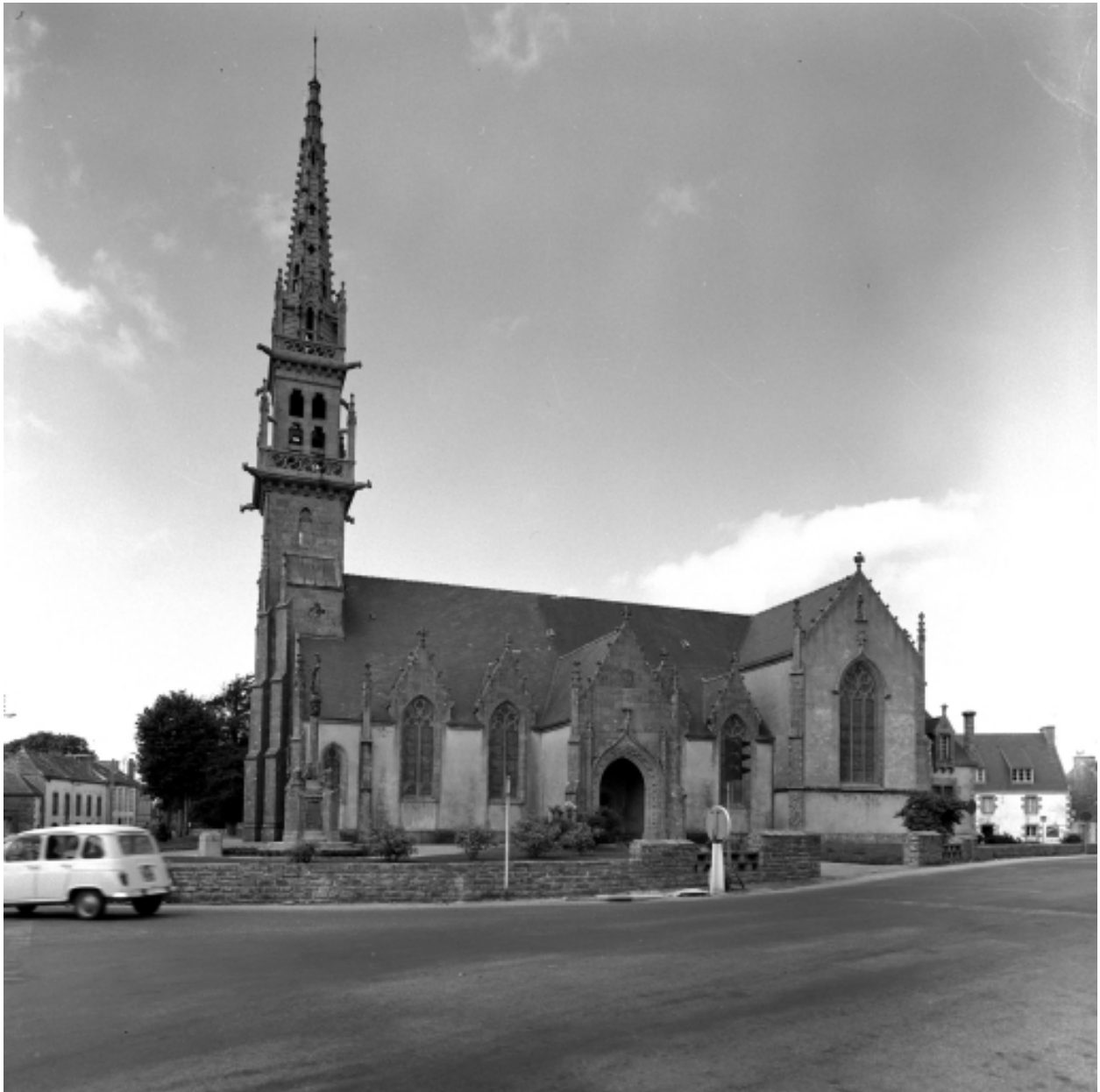
Plonévez-Porzay, église paroissiale Saint-Milliau : vue générale sud, état en 1970
