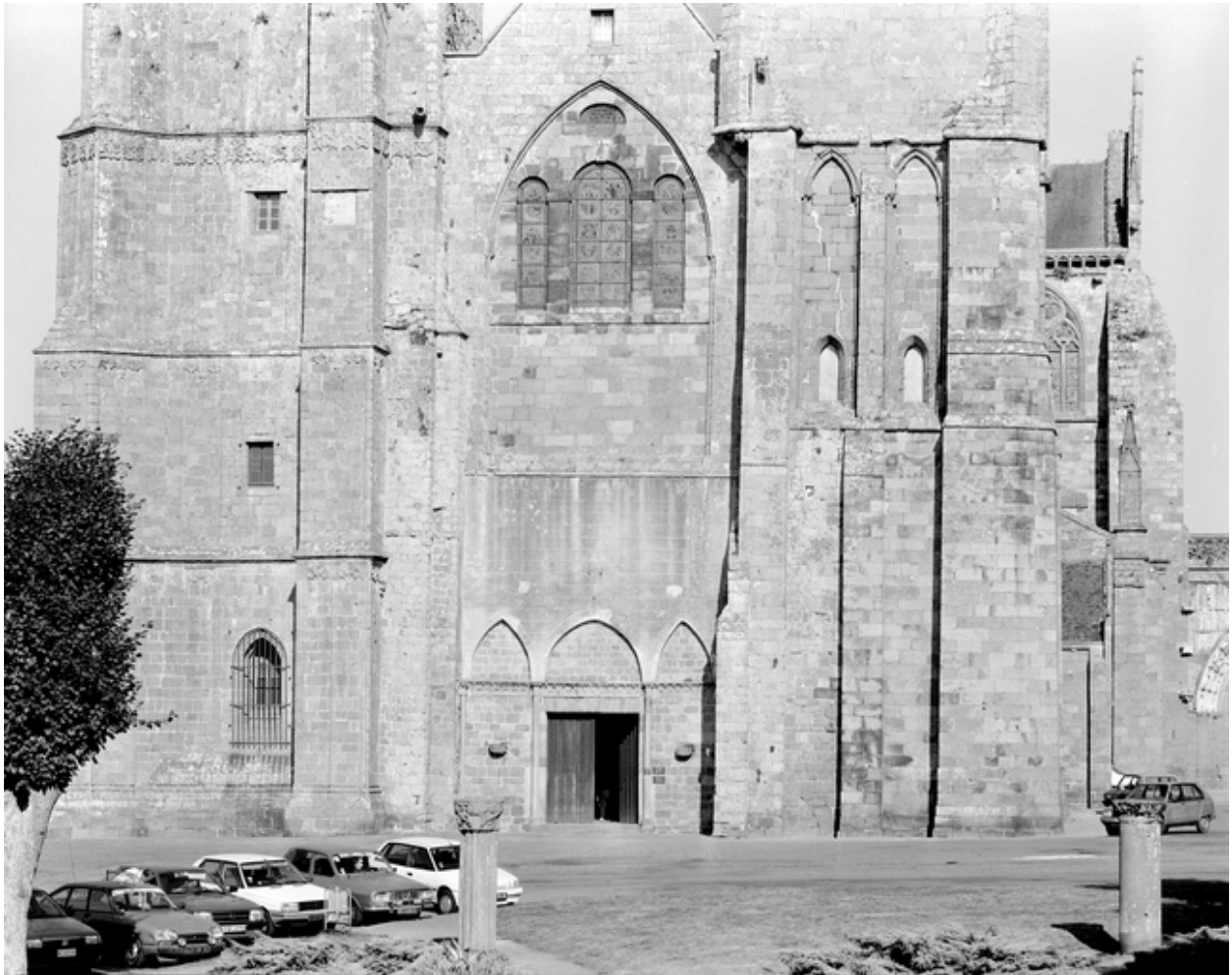
Façade ouest : premier niveau
