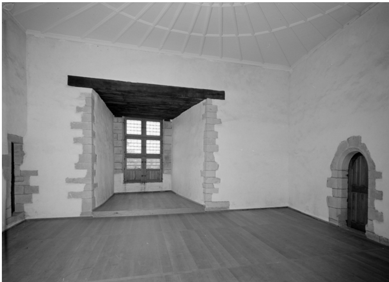
Tour nord-ouest, pièce du troisième niveau, mur sud.
