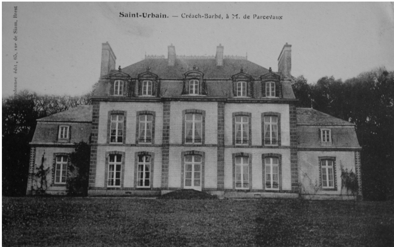
Vue : façade principale
