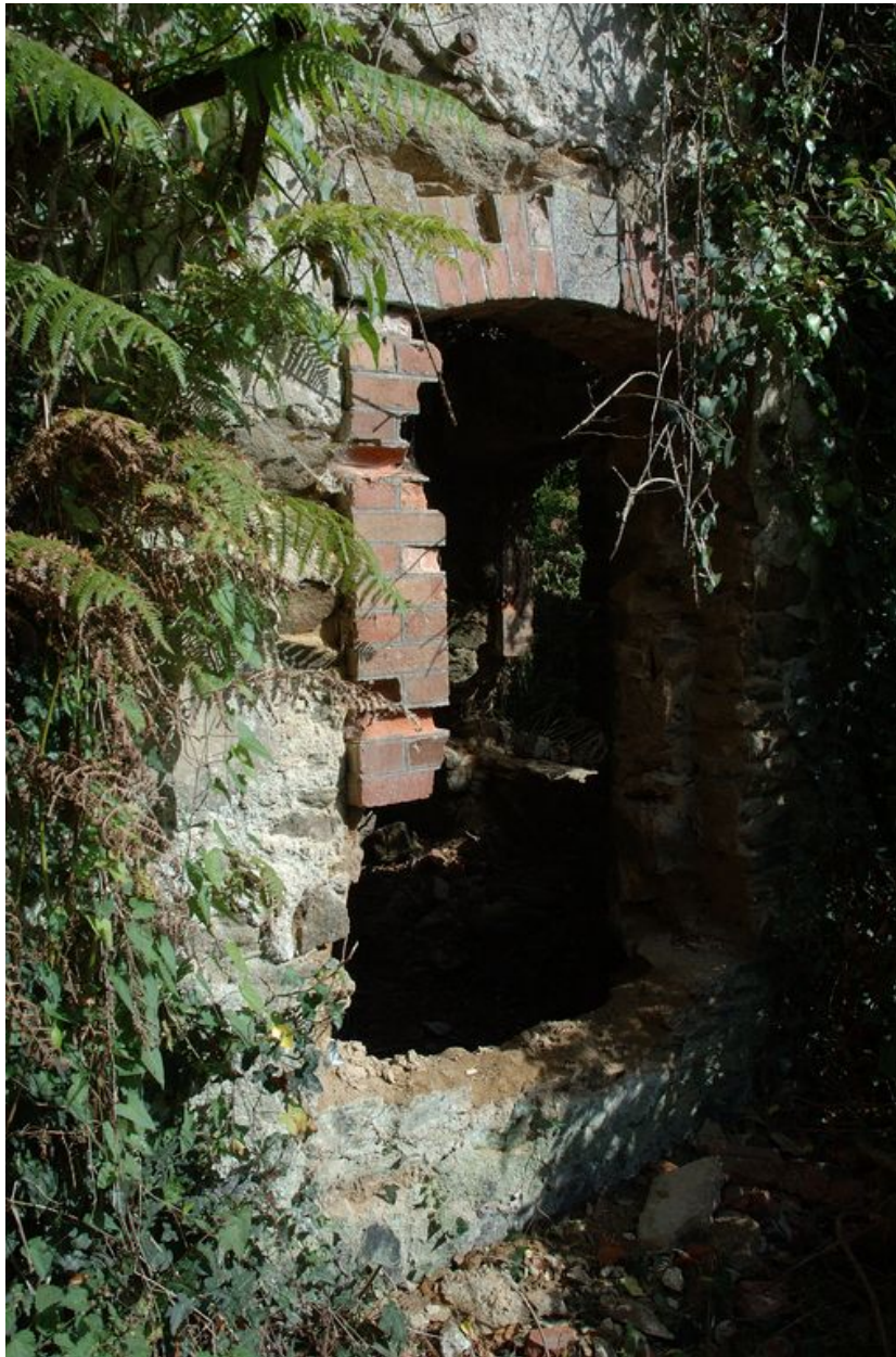
Vue de la caserne (état en 2007)
