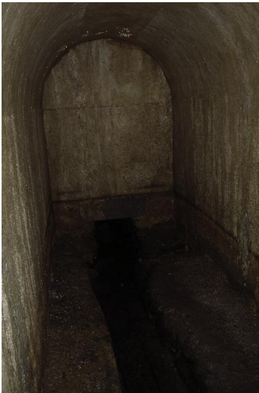
Le Palais, enceinte urbaine, porte Vauban, canalisation en sous-sol.
