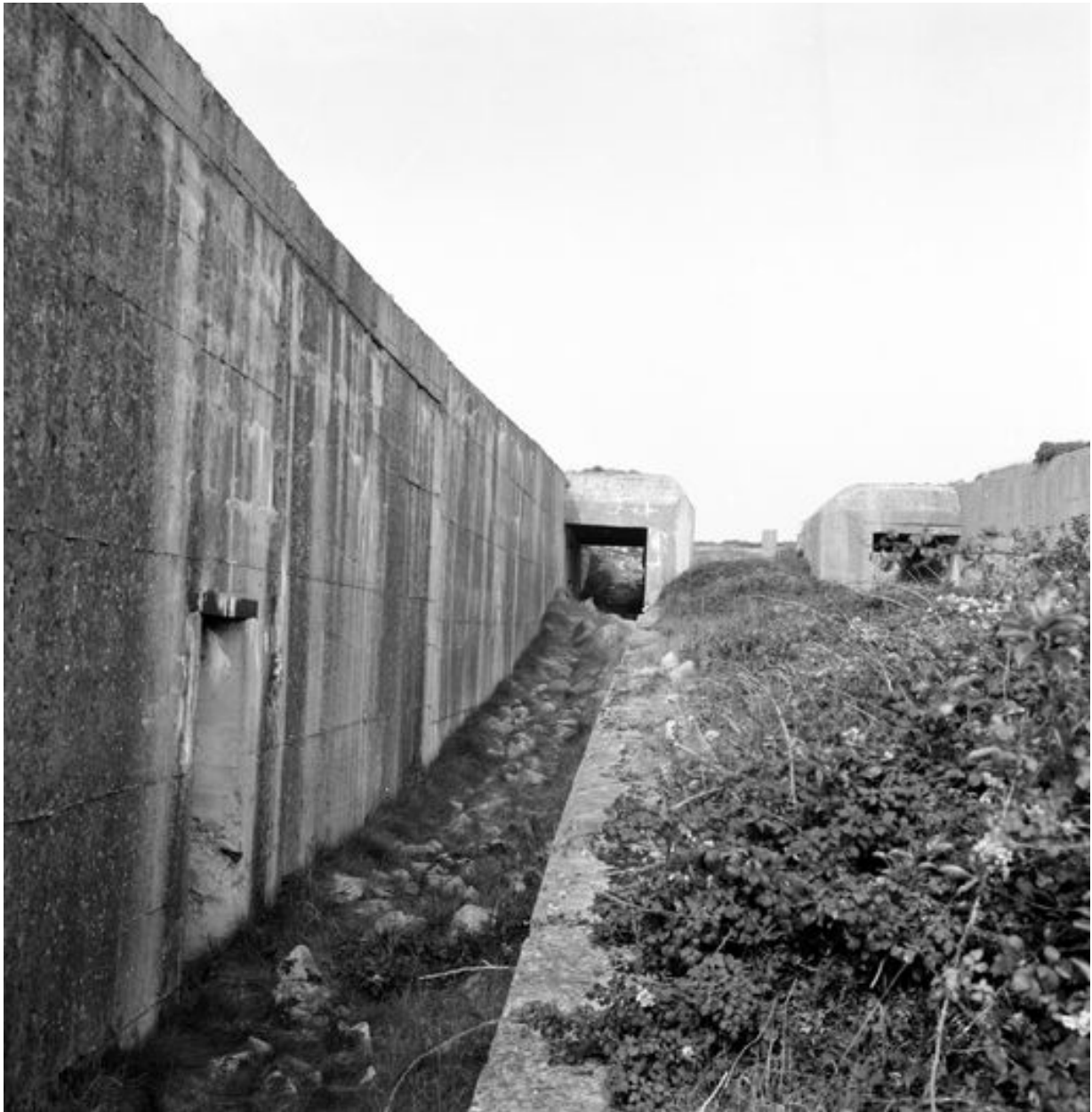
Vue de la rampe d'accès pour canon de 22 cm Schneider en 1969. A gauche : magasin de munitions
