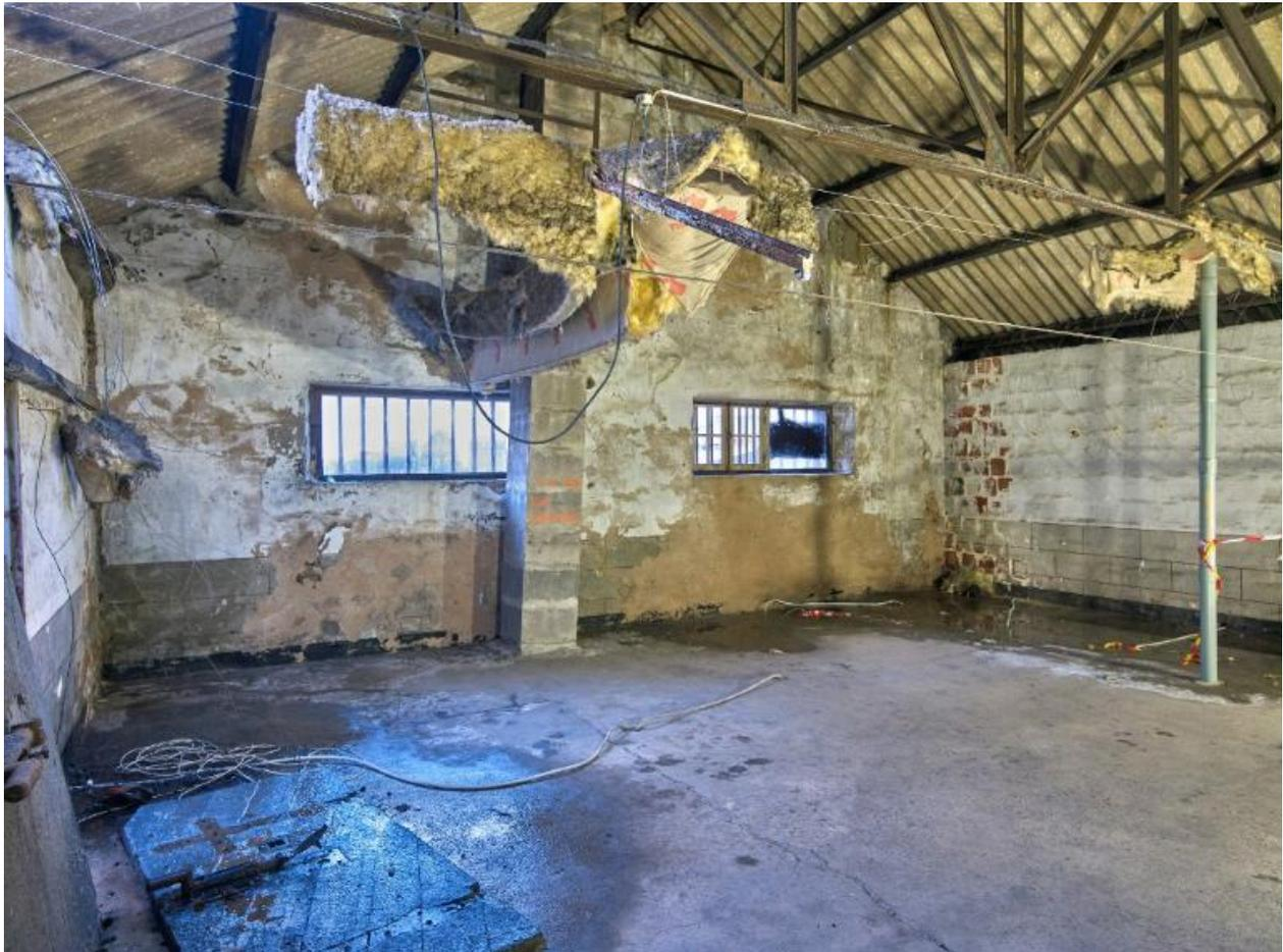
Vue du niveau de comble : extrémité nord. La charpente métallique porte des plaques de fibrociment ; fenêtres donnant vers le nord. Les murs conservent leur enduit et leur peinture d'origine. A gauche, portes de cellule déposées
