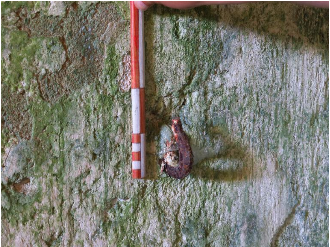
Groix, batterie du Bas-Grognon, corps de garde crénelé, chambrée, crochet pour hamac.
