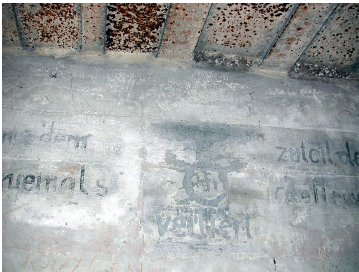
Vue intérieure : peintures murales (état en 2002)
