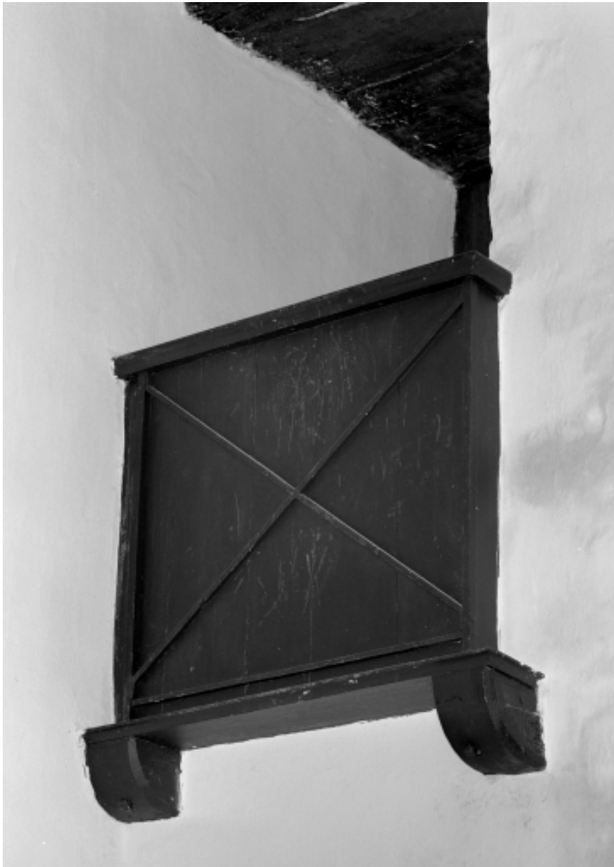
Choeur : loge de bois, vue générale.
