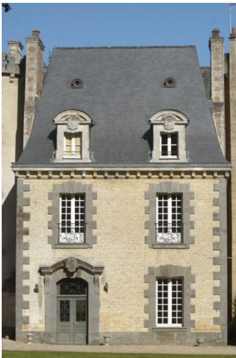
Logis, façade arrière, pavillon central
