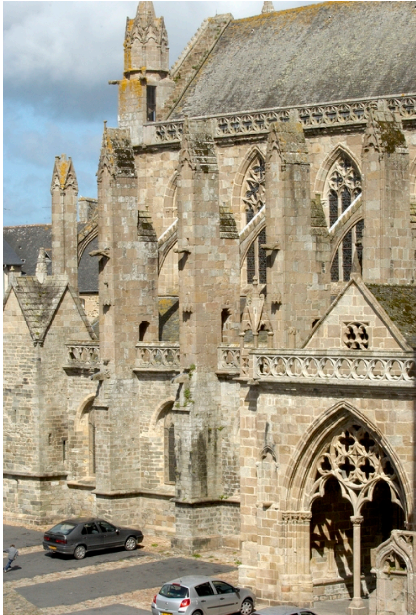
Détail de l'élévation sud de la nef
