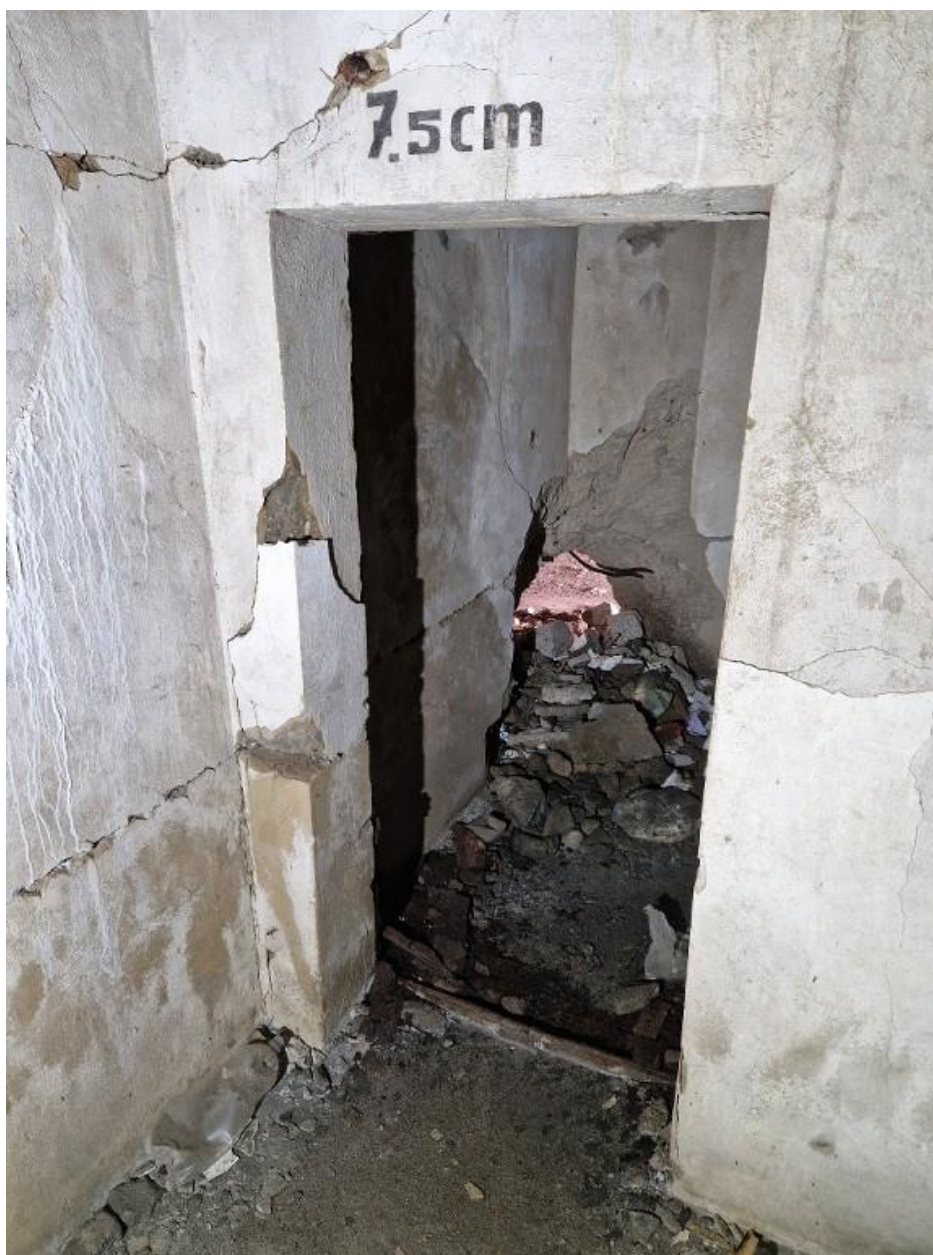
Vue intérieure du bunker - cuve nord pour canon de 34 cm avec magasins de munitions. Ce bunker conserve des marquages
