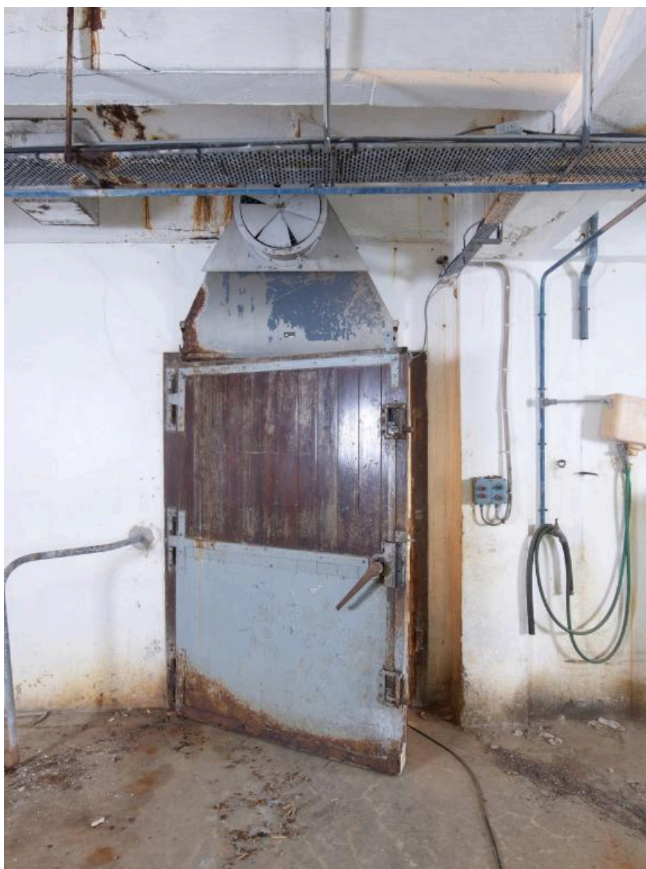
Porte étanche avec système de refroidissement
