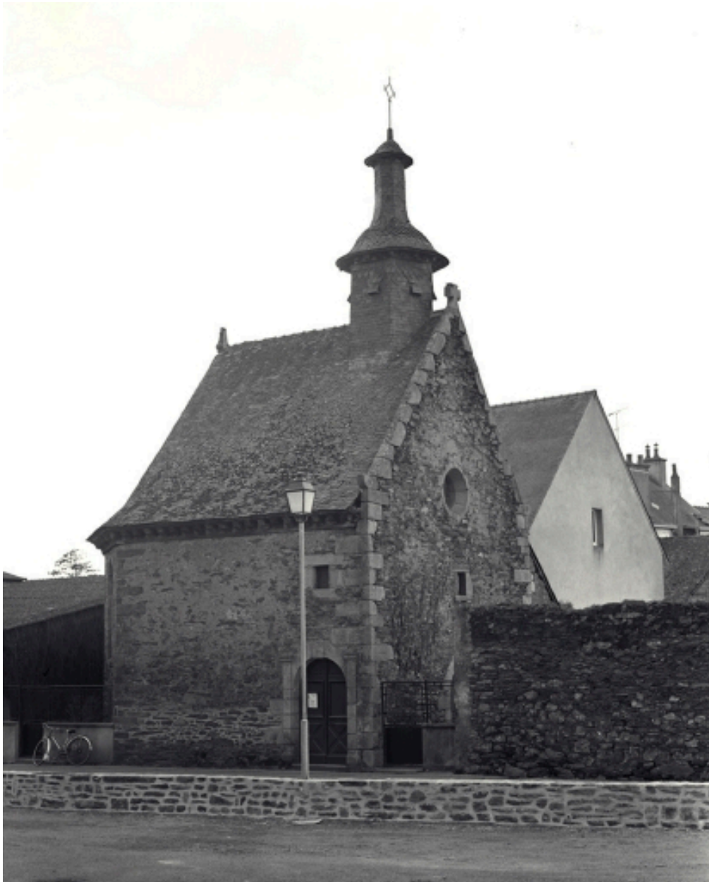
Elévation nord-ouest ; vue générale
