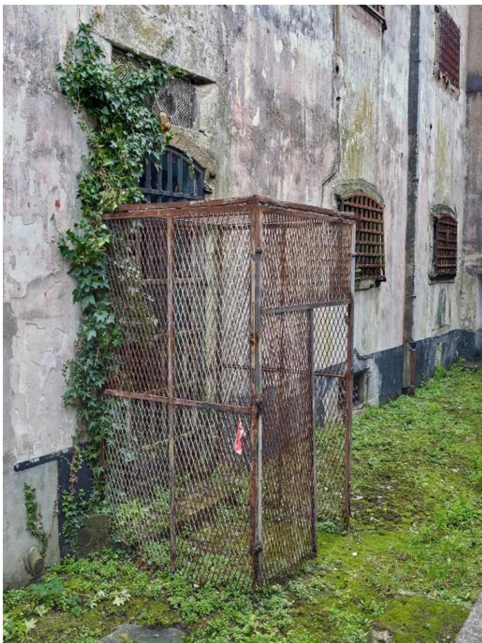
Vue de détail de l'élévation ouest du bâtiment carcéral : cage constituée de grillage métallique faisant sas et protégeant l'entrée de la cour, elle-même dotée d'une grille. Le mur conserve son enduit et sa bande de propreté peinte en noir
