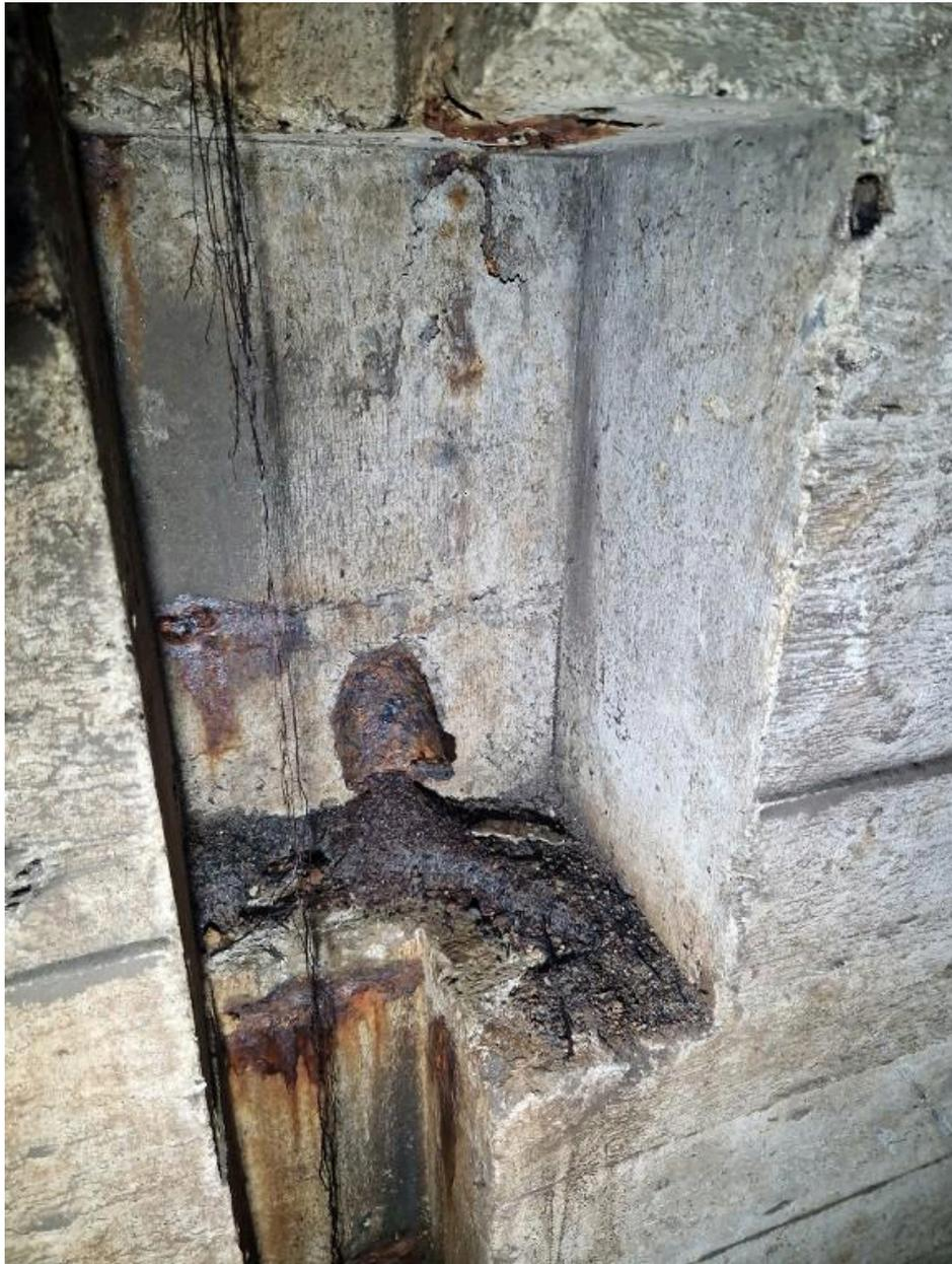
Vue de l'entrée nord : détail du passage d'antenne avec conduite de câble (pour l'alimentation électrique ?)
