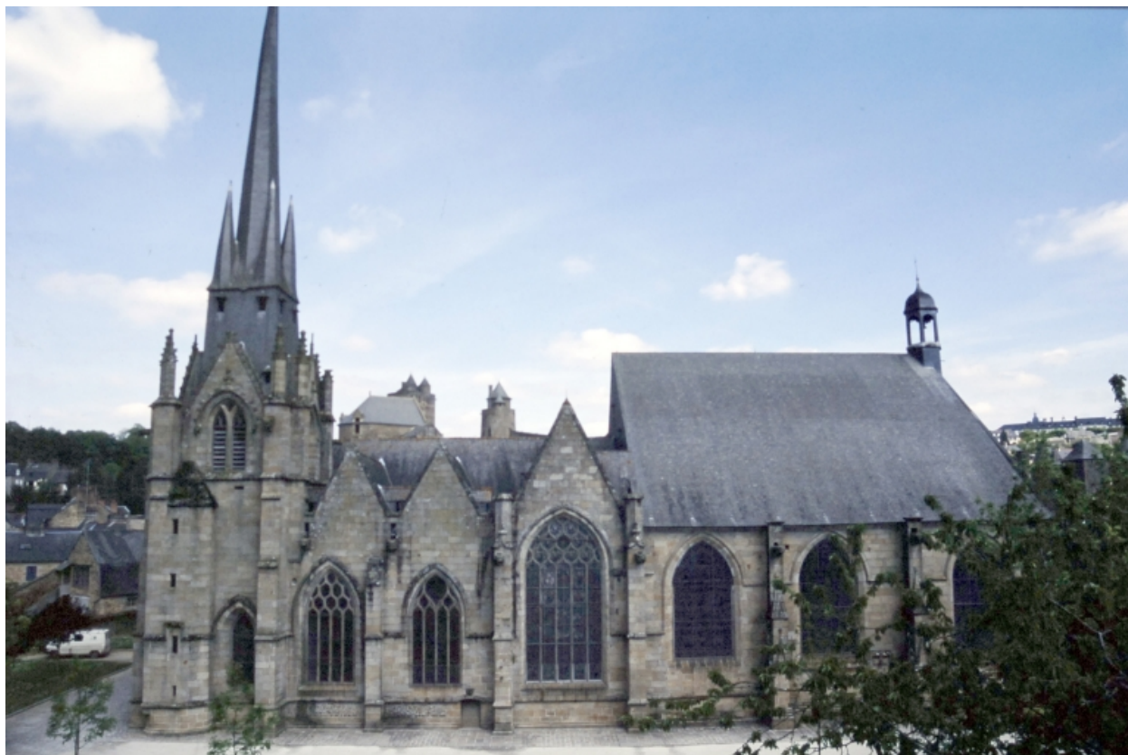
Elévation sud : vue générale.
