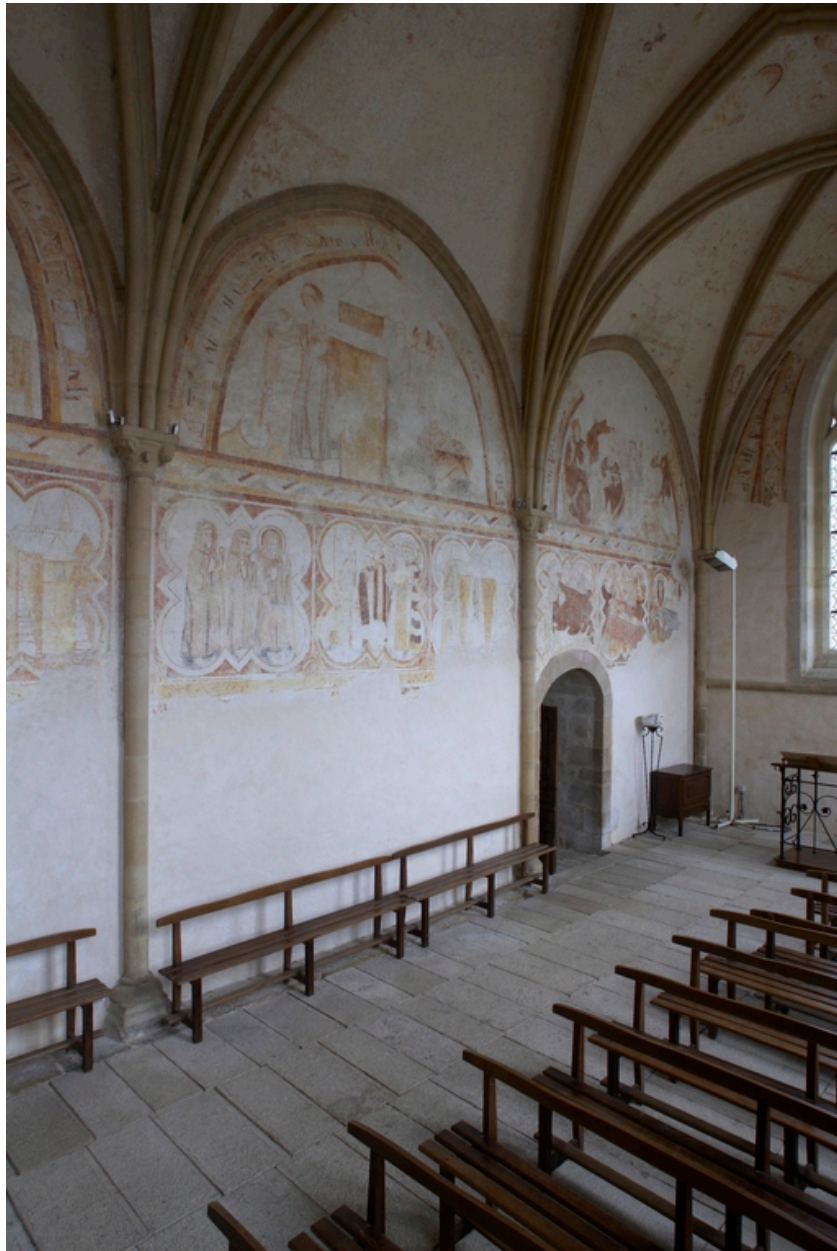
Chapelle Saint Vincent, vue vers le mur nord
