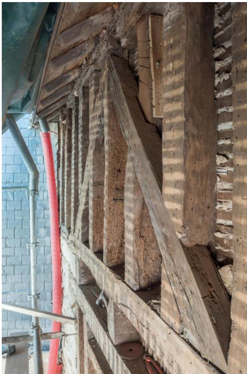
Deuxième étage, pan de bois de la façade nord en cours de restauration.
