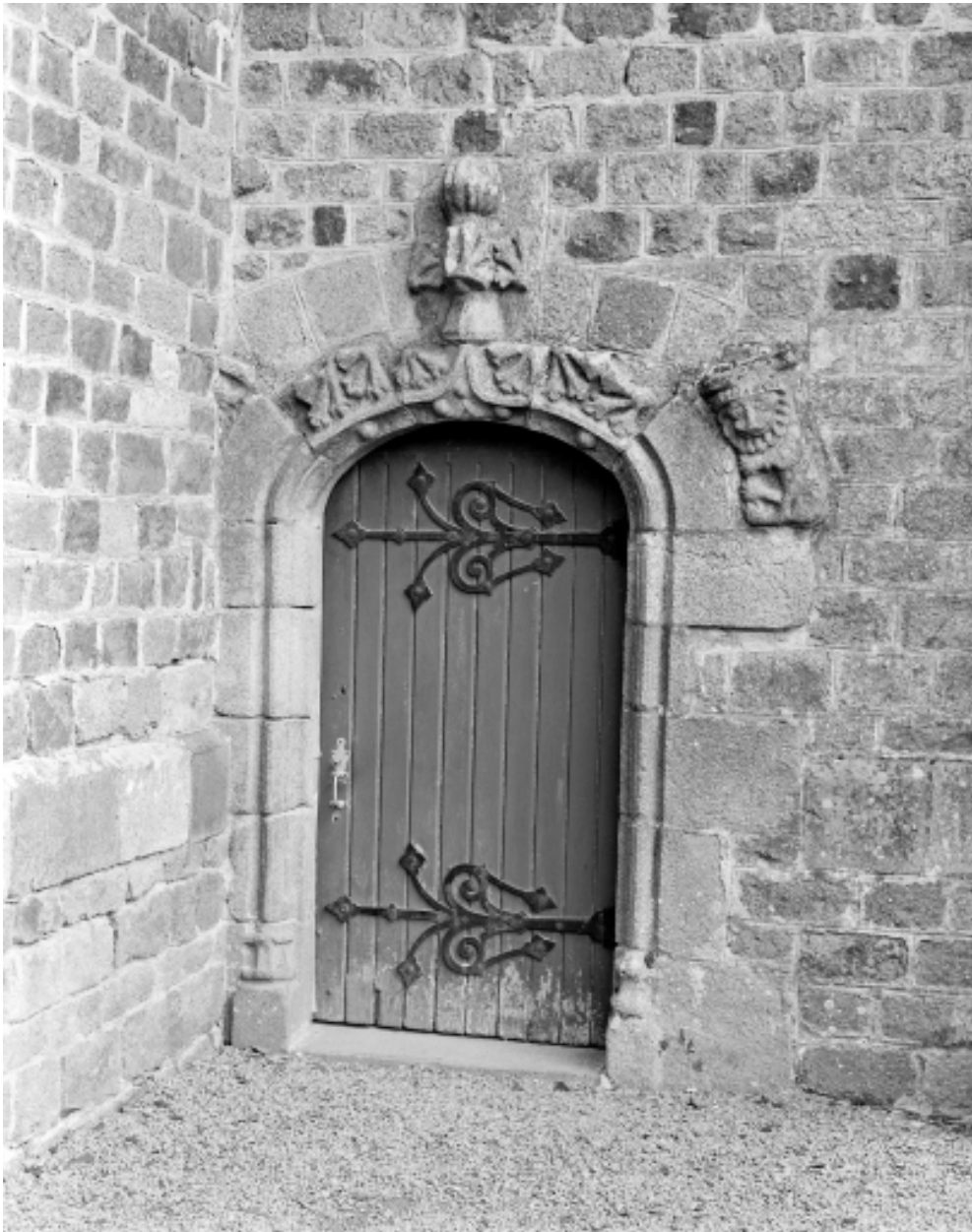
Elévation sud, bras du transept, porte : vue générale
