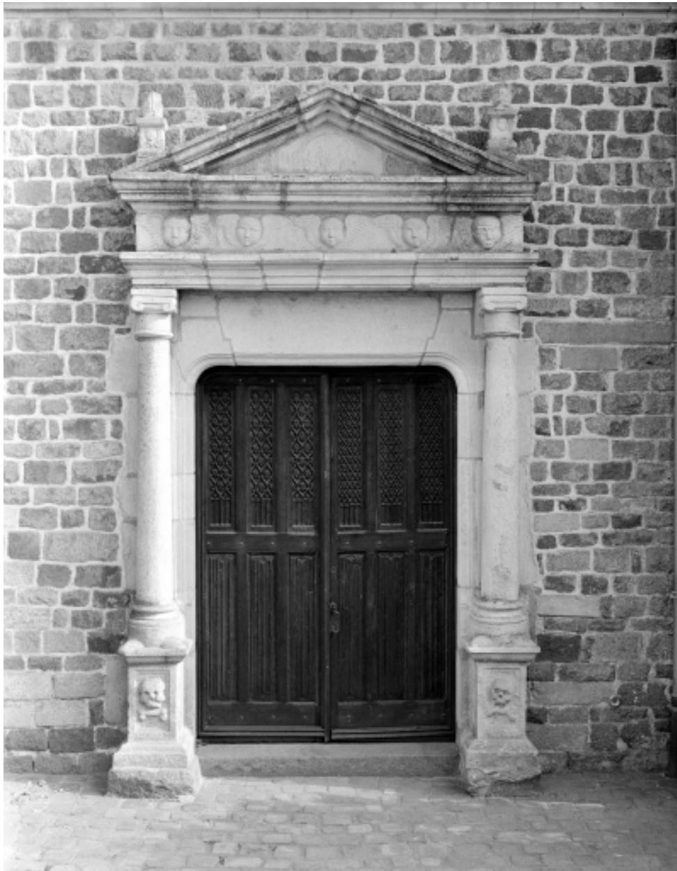
Elévation sud, porte : vue générale.
