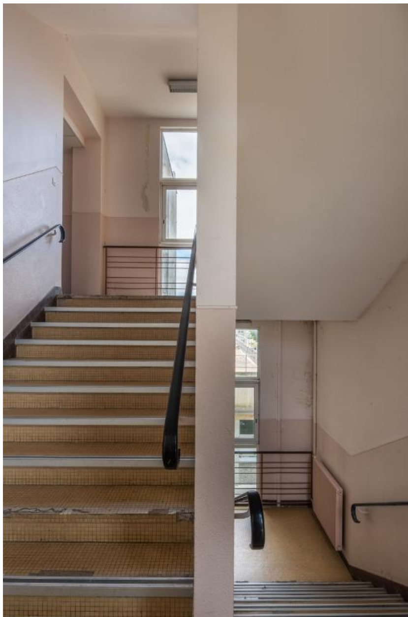
Escalier dans-œuvre. Péron et Weisbein, architectes, 1967-1968.
