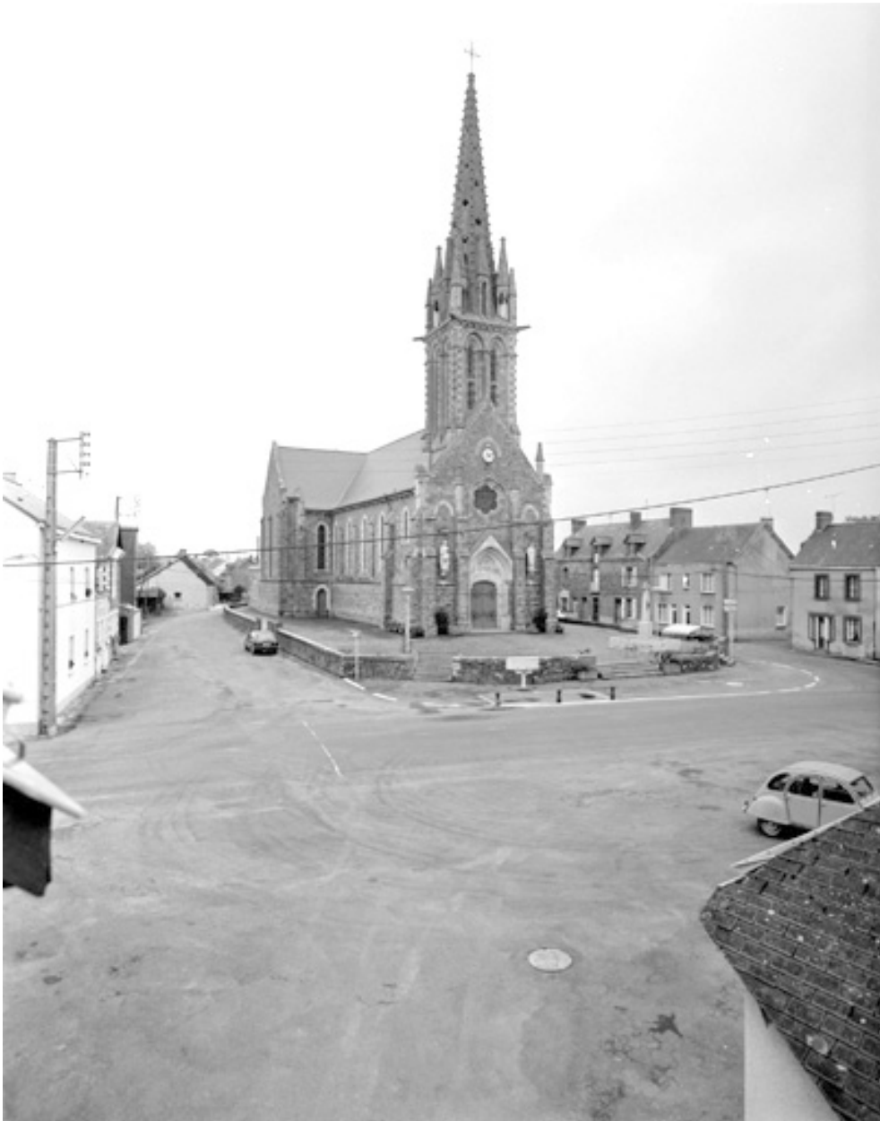
Élévation nord-ouest : vue générale
