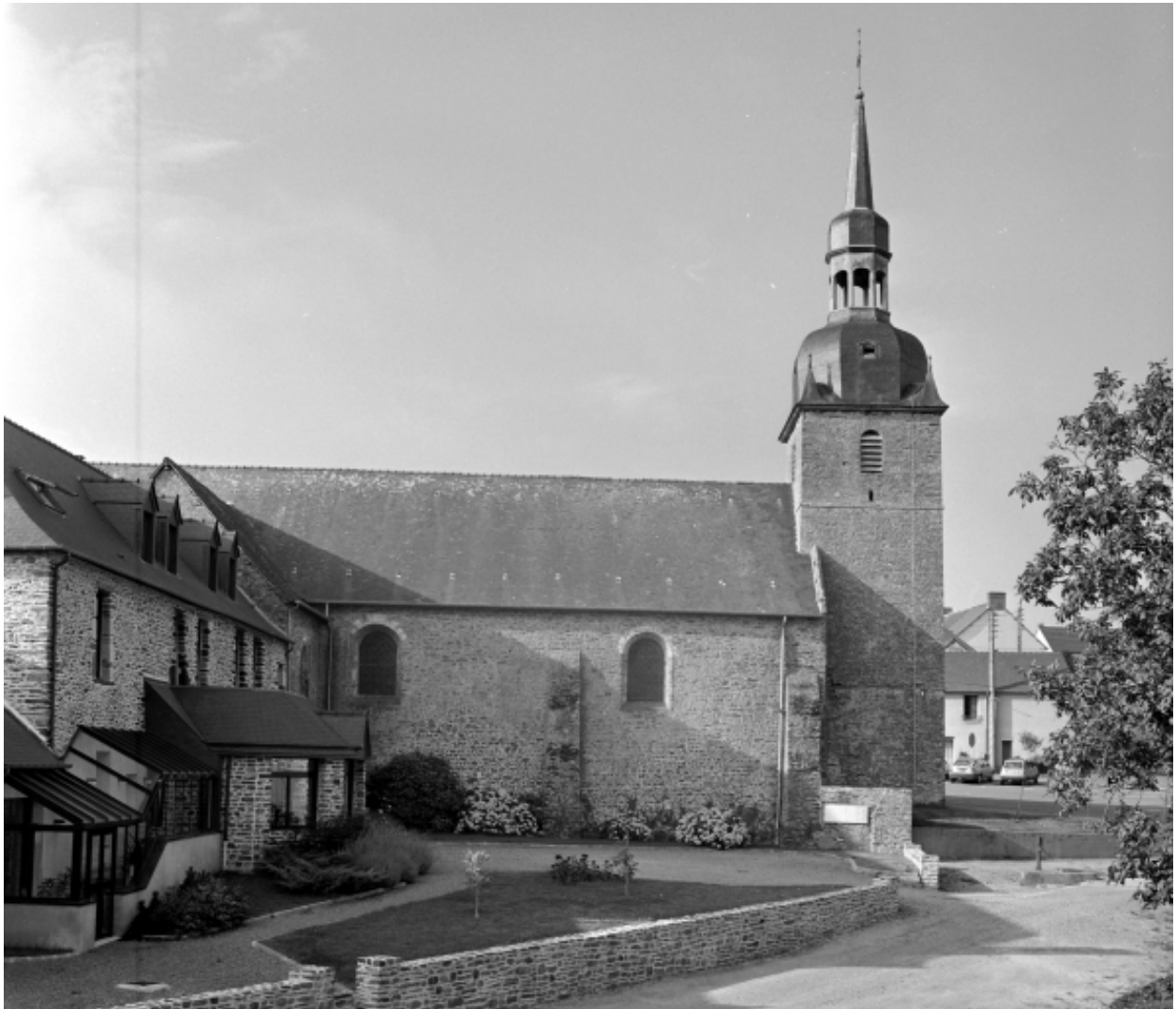
Elévation nord, partie ouest : vue générale
