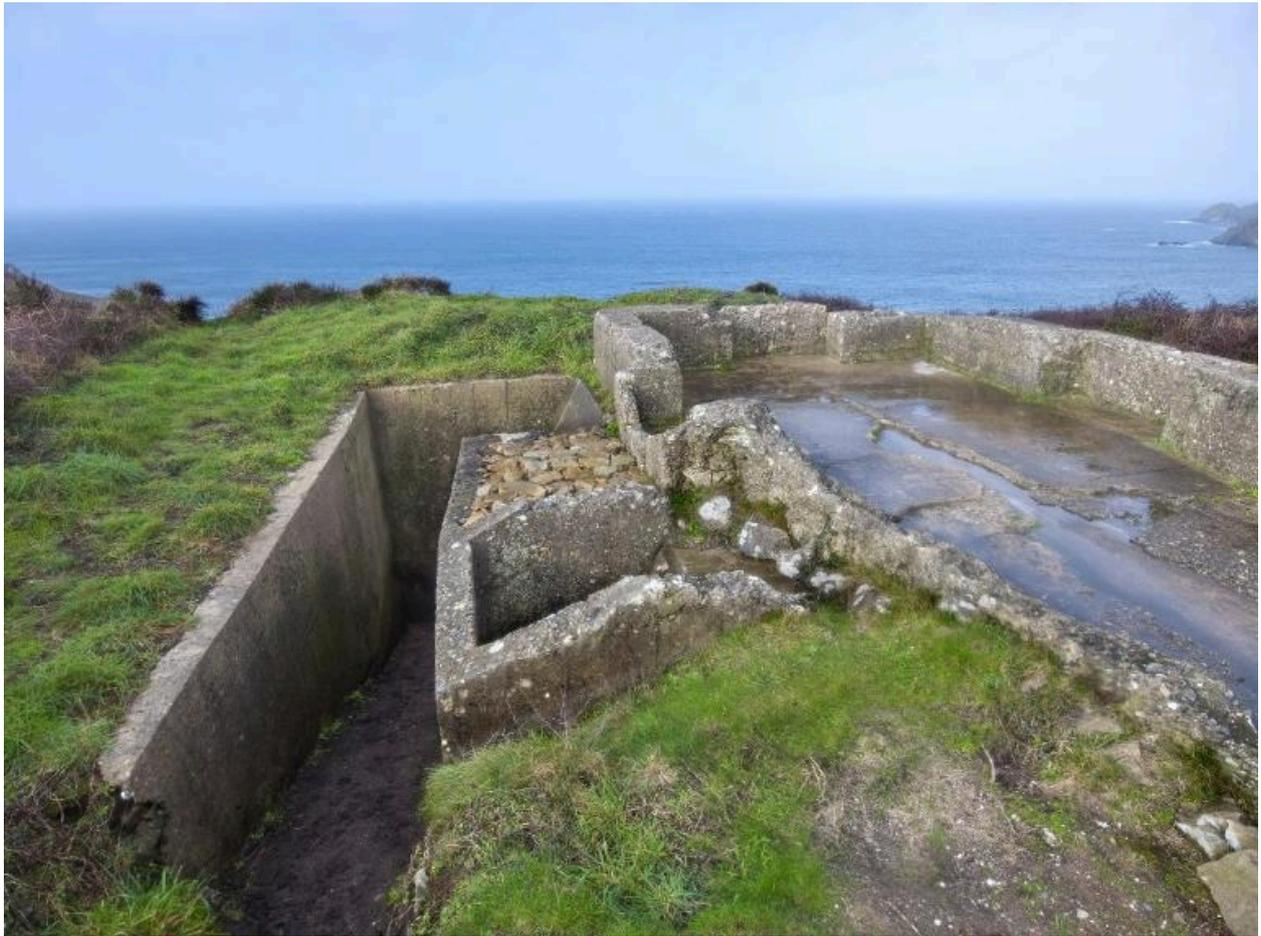
Vue du bunker - abri de type VF 2a pour 10 hommes : tranchée d'accès ouest et puits de la sortie de secours. Sur sa dalle de couverture (à droite) se trouvait un projecteur protégé par un parapet
