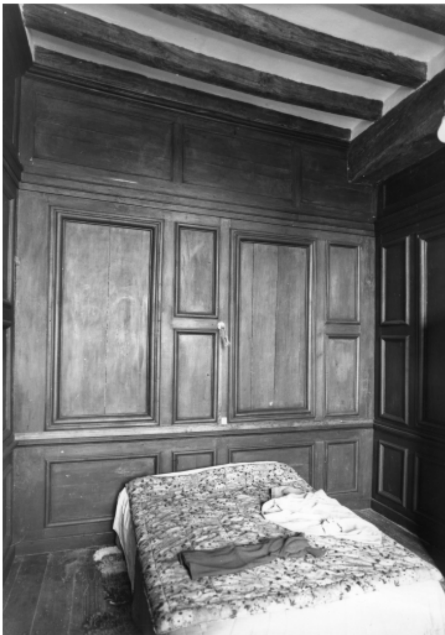
Corps de logis principal, étage, chambre lambrissée (18e siècle), mur nord. Etat en 1978.
