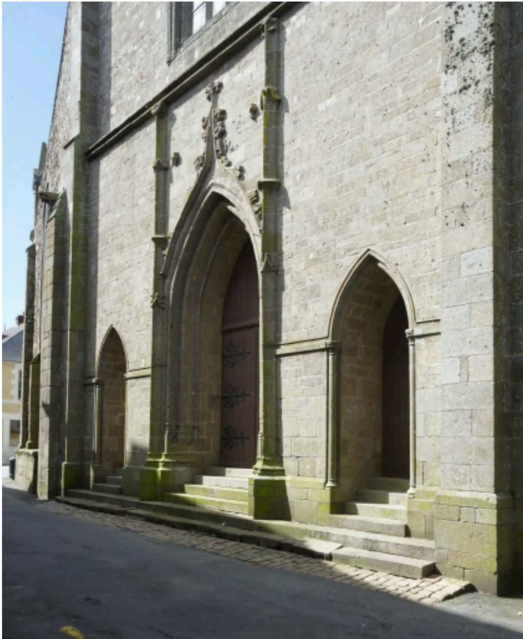
Eglise : portail ouest
