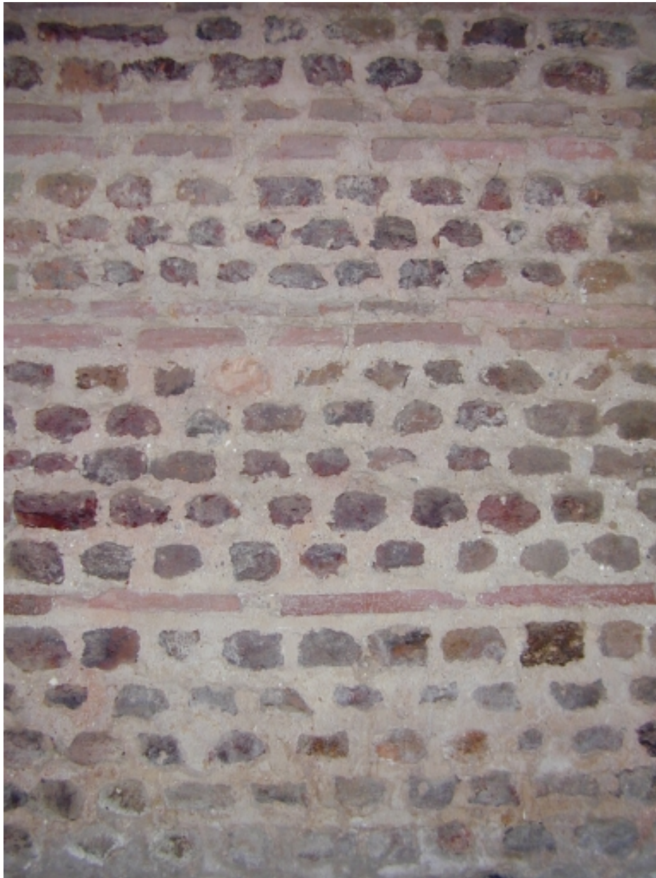
Vue intérieure, détail, appareillage du mur sud
