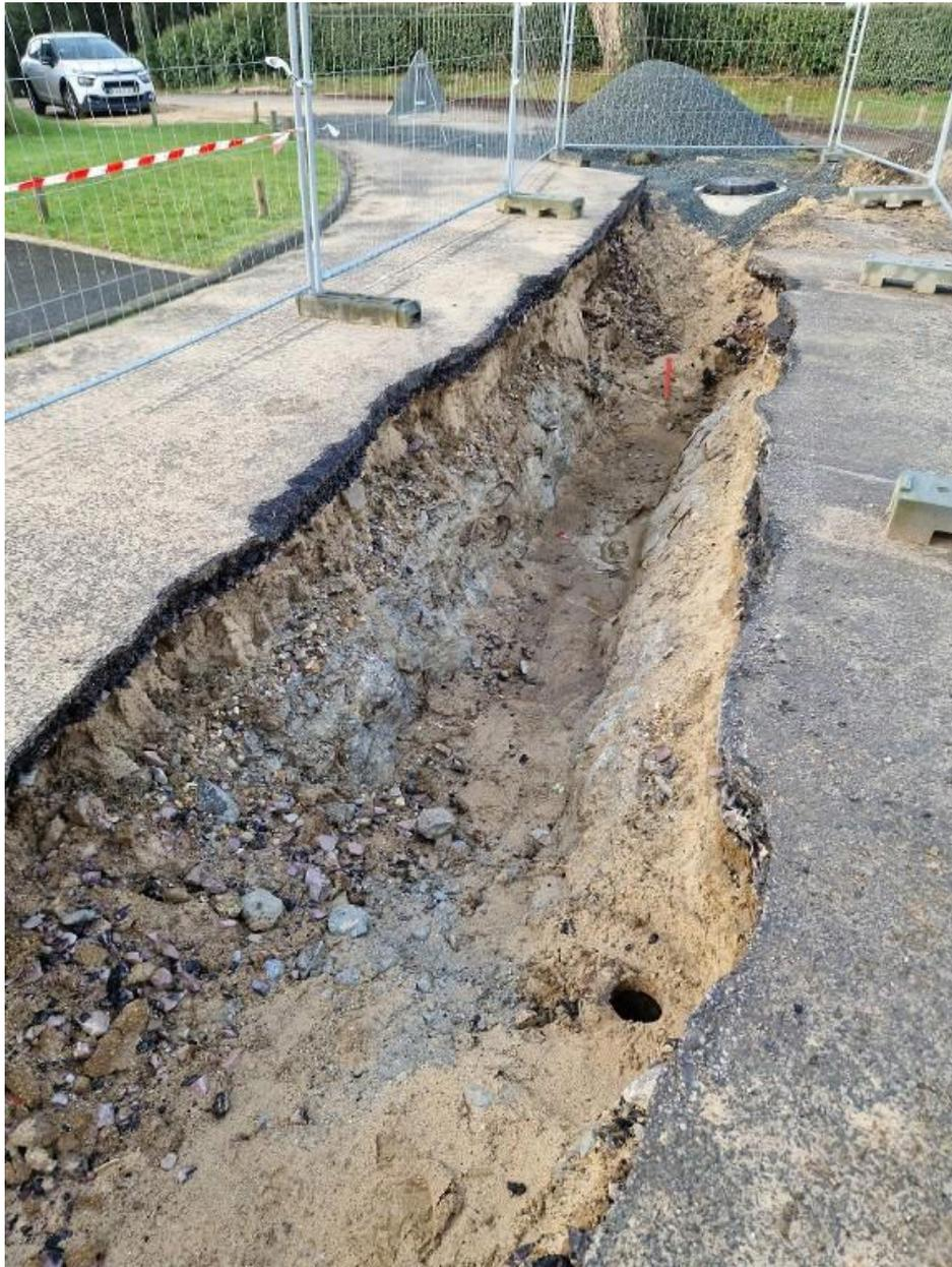
Vue de la dalle de couverture : tranchée aménagée dans le béton armé pour le passage d'un tuyau d'assainissement. Au premier plan à droite, l'orifice de sortie du puits de périscope
