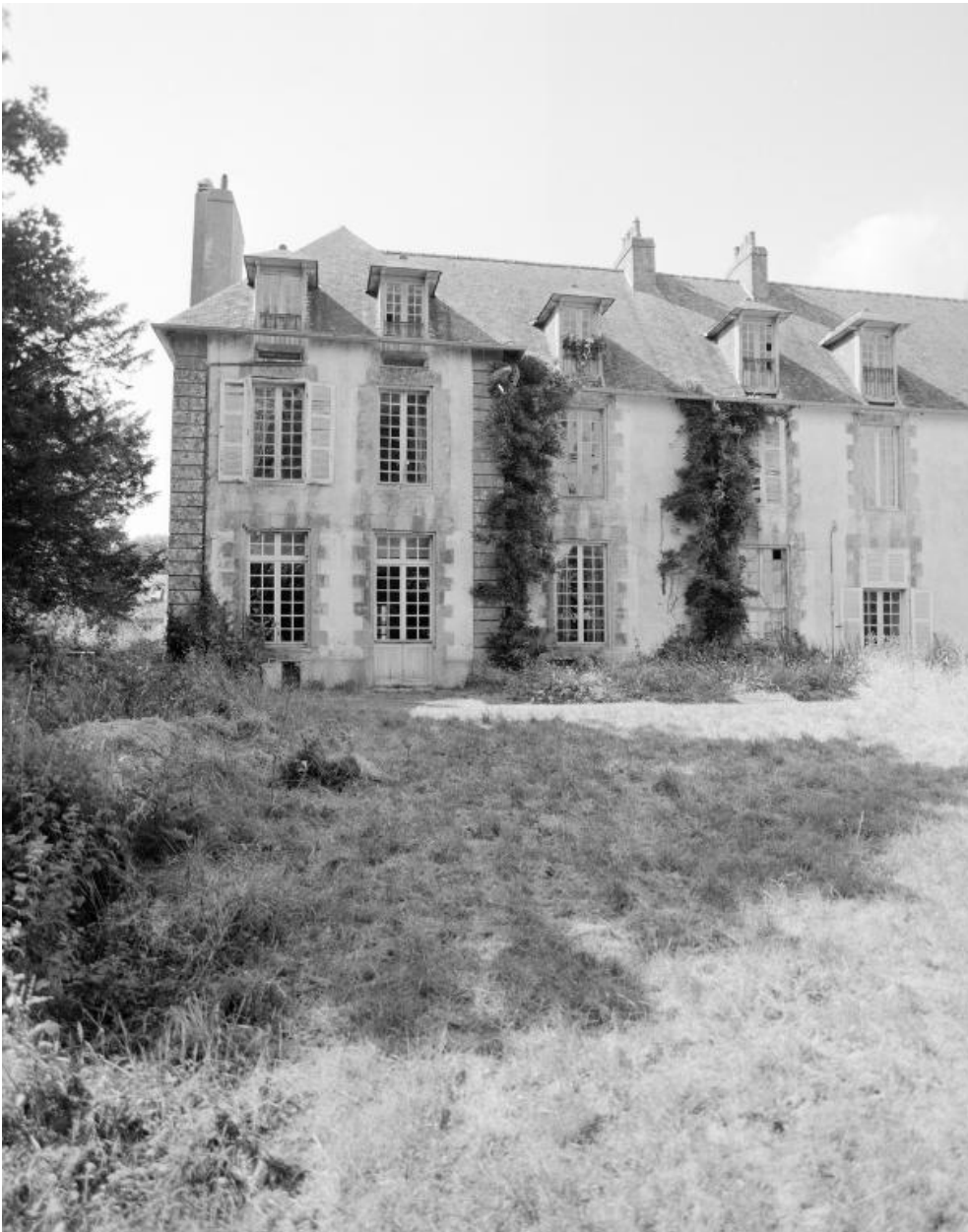
Elévation sud, aile ouest, pavillon ouest.
