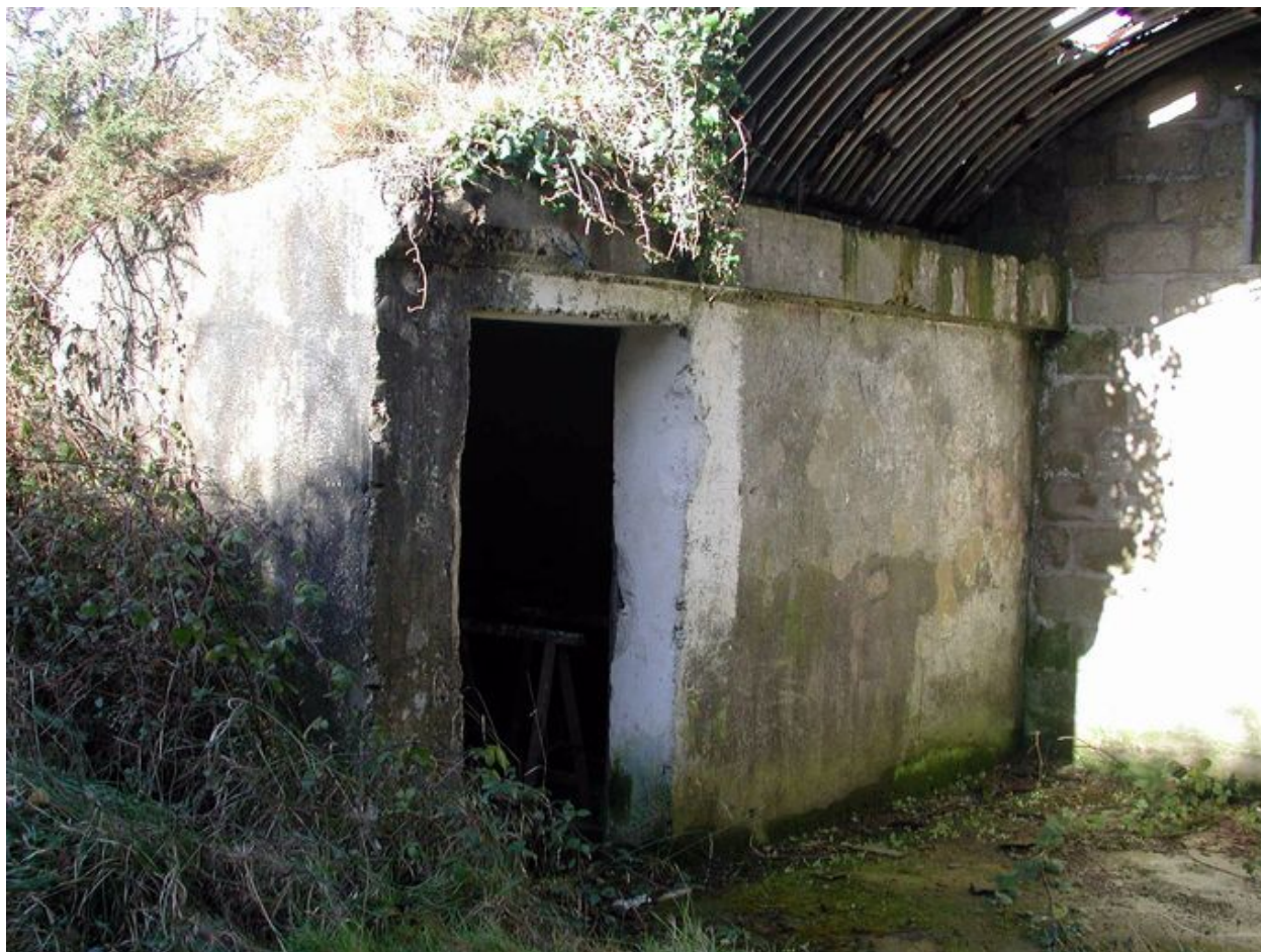
Vue d'un abri en béton armé (état en 2007)
