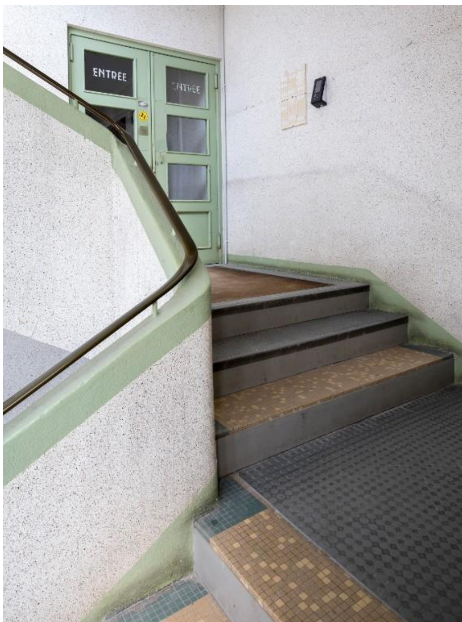
Escalier et palier de la criée de 1952
