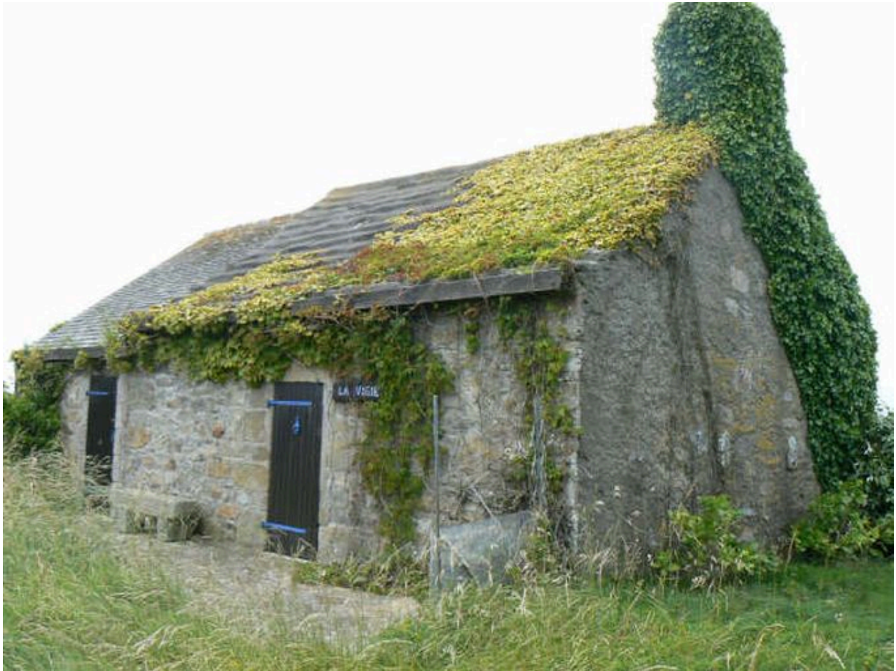
Vue générale du corps de garde de Penhoat
