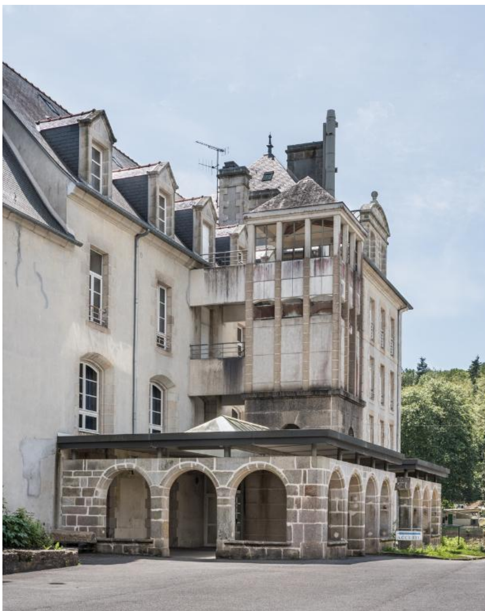
Bâtiment de l'ancien séminaire, aile nord-ouest, façade nord-ouest.
