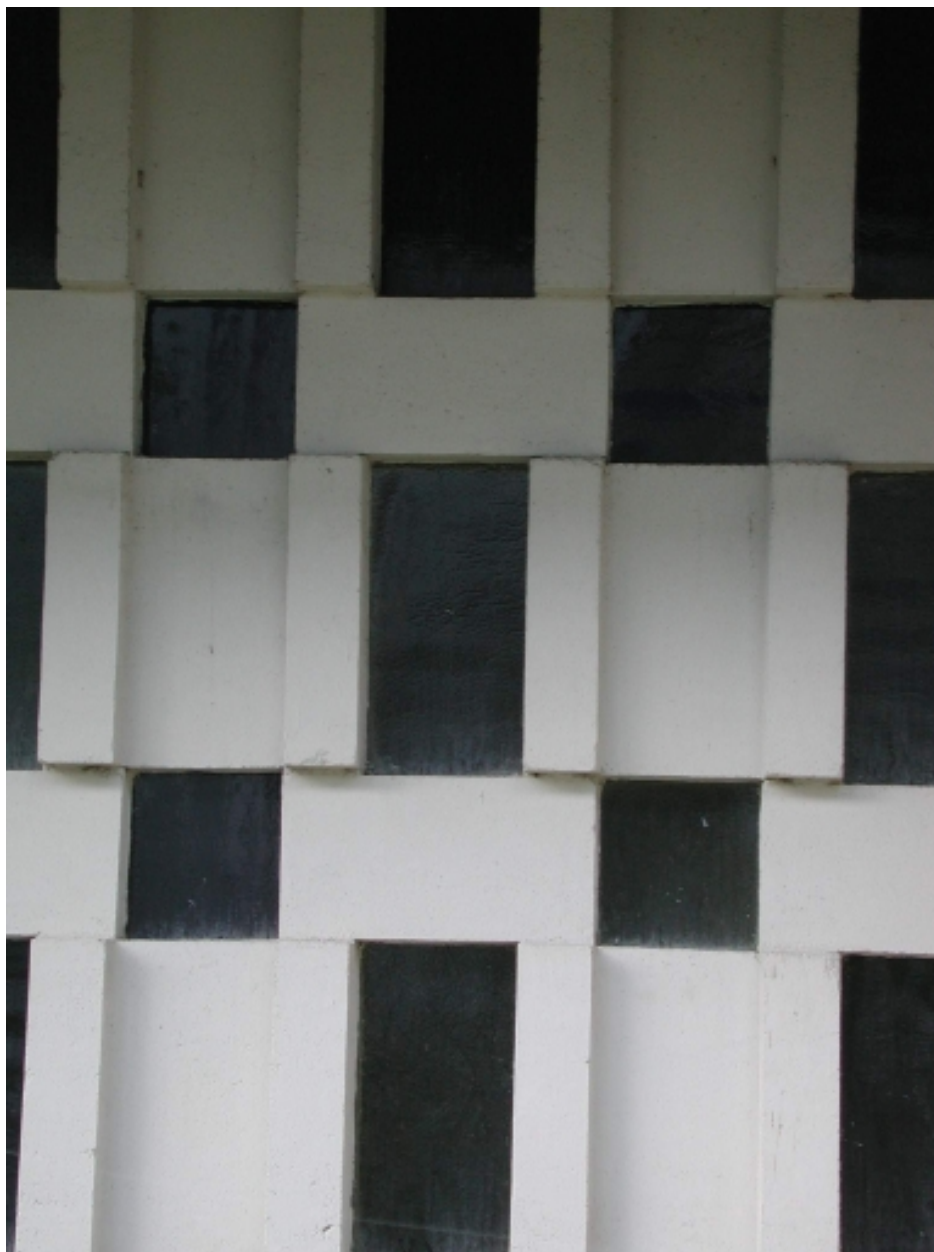
Détail du mur sud
