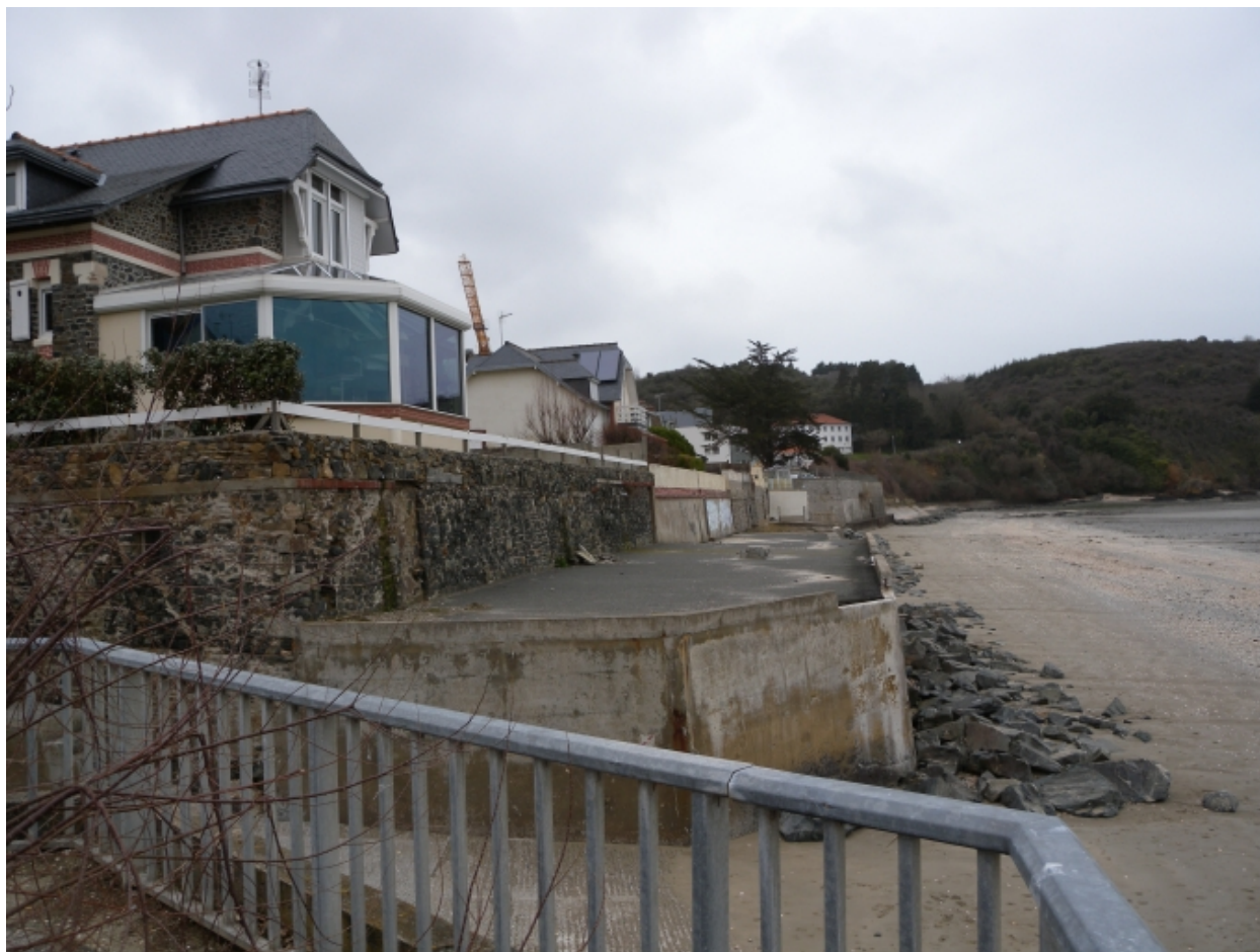
Vue du bâti littoral contemporain en front de mer, près de la rampe d'accès à la grève
