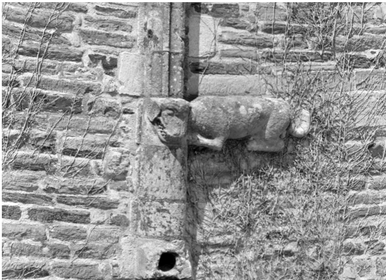
Aile nord, côté cour, cinquième tuyau de descente.
