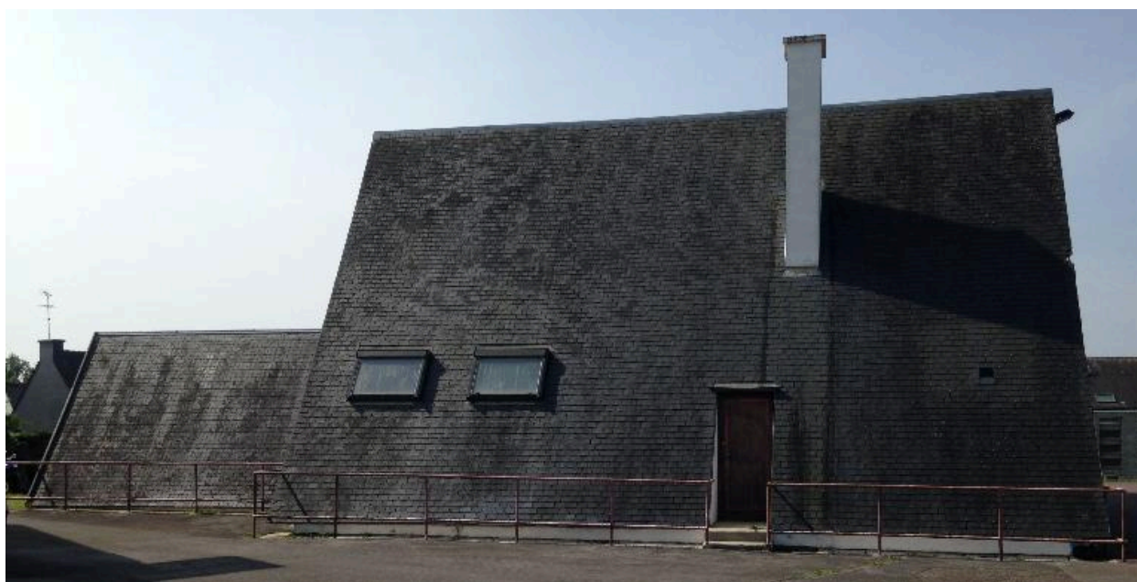
Façade nord et extension du gymnase
