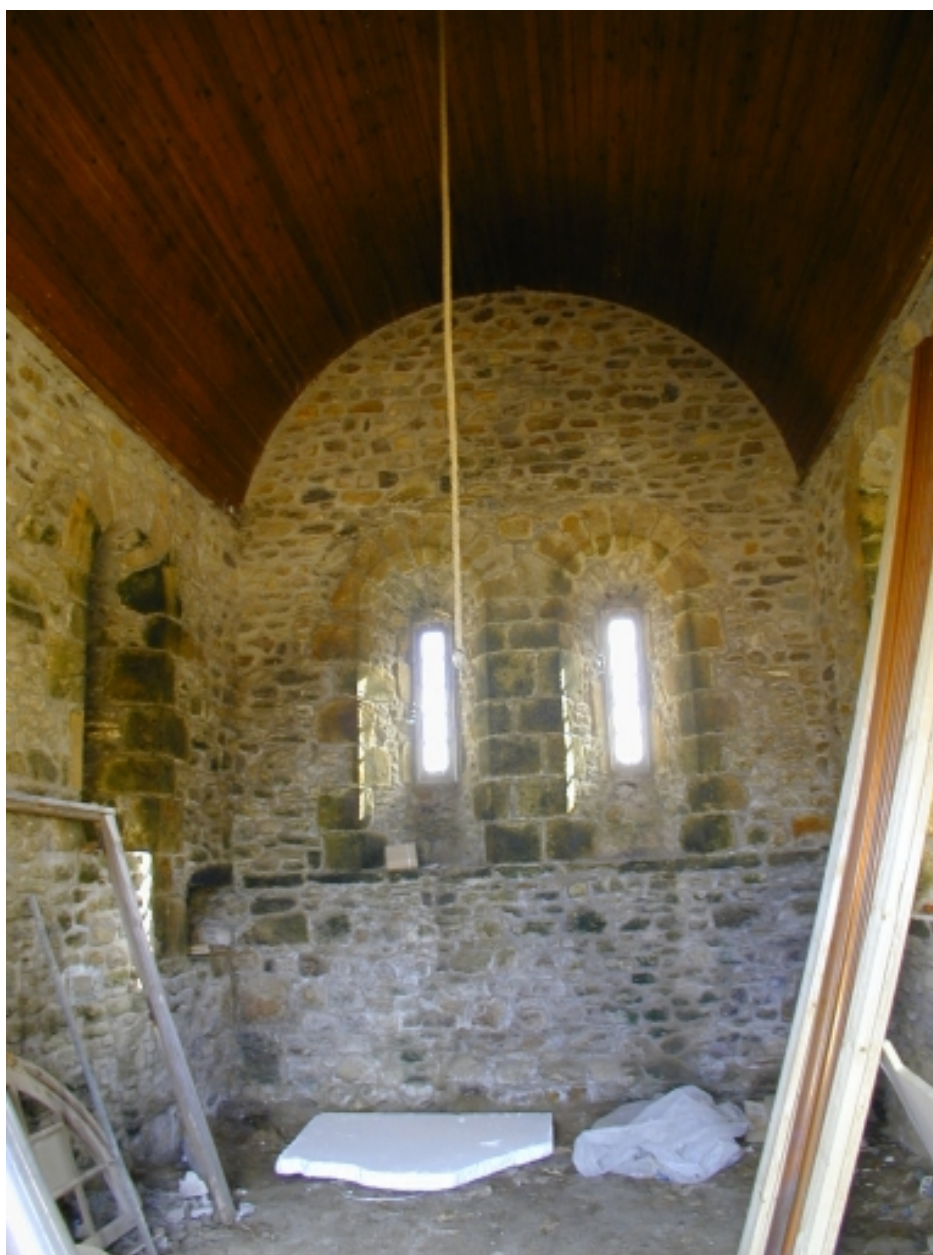
Vue intérieure du chevet et de la voûte en cours de restauration, 2004 (SRA)
