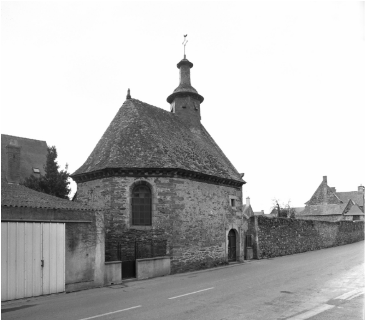
Elévation nord-est ; vue de situation
